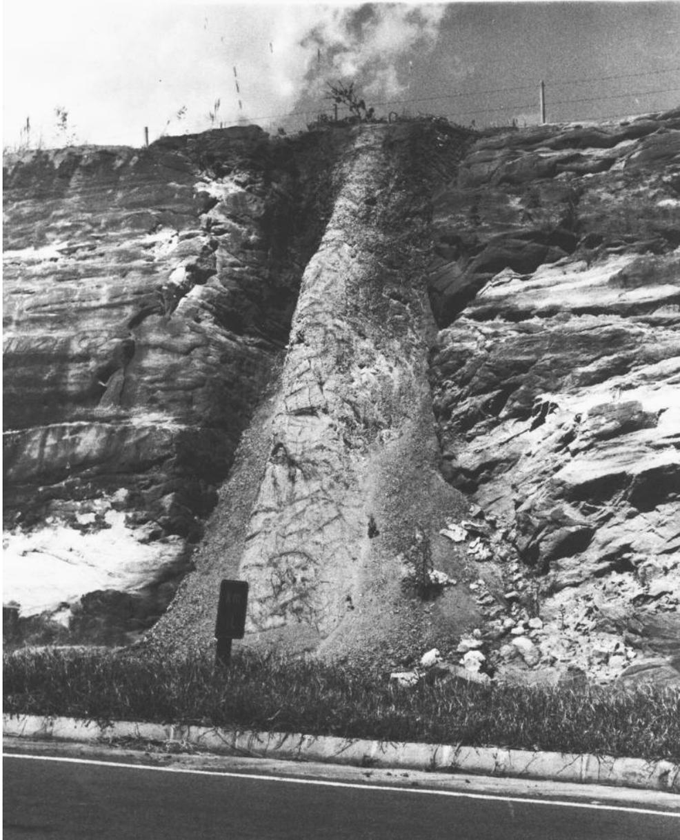
Figura 14. Dique de diabásio intrusivo na Formação Pirambóia (Serra da Fartura, divisa Paraná-São Paulo). Observar as zonas de intenso fraturamento no arenito encaixante e no próprio dique
