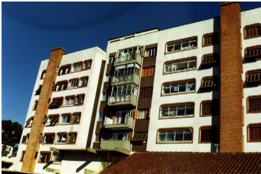
Foto 9: Prédio das Hortênsias - uma ferida no centro da cidade
