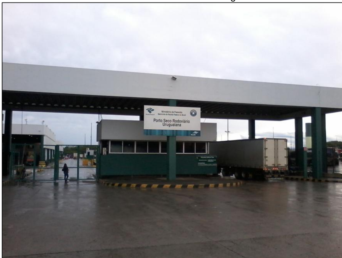
FOTO 29: Entrada do Porto Seco Rodoviário de Uruguiana
