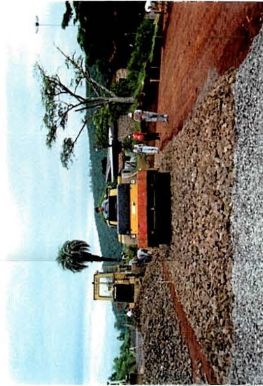
Execução de camada de macadame seco com basalto alterado - Exécution de couche de base du type macadam à sec avec basalte altéré - Execution of dry macadam layer using basalt alteration
