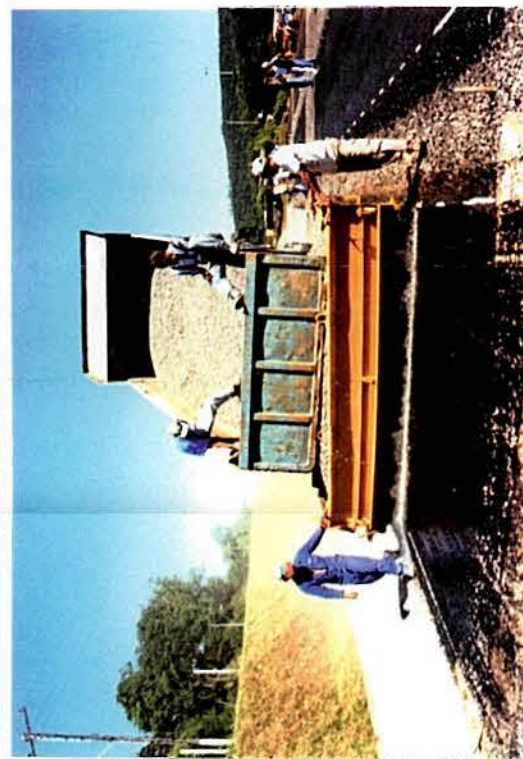
Execução de camada de macadame seco com basalto alterado - Exécution de couche de base du type macadam à sec avec basalte altéré - Execution of dry macadam layer using basalt alteration
