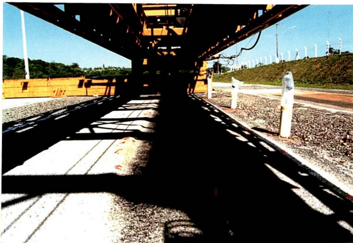
FIGURA 6.9 - Tensiômetros instalados na borda do Setor 0413
