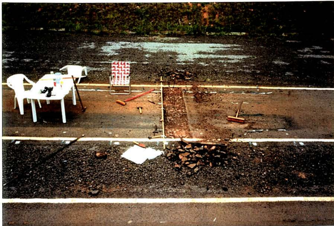
FIGURA 6.12 - Retirada do revestimento na avaliação post-mortem da Pista 01
