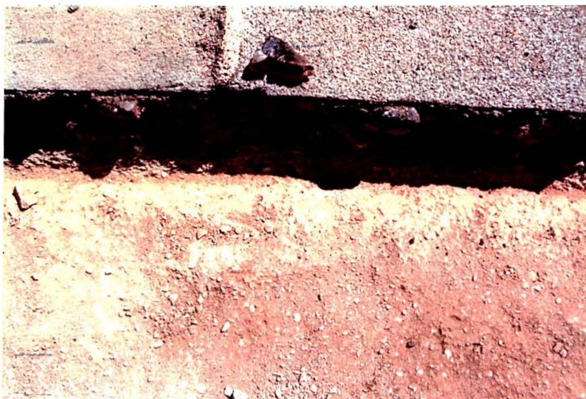
FIGURA 7.15 - Quebra de agregado da Jazida E na borda interna do setor 0413
