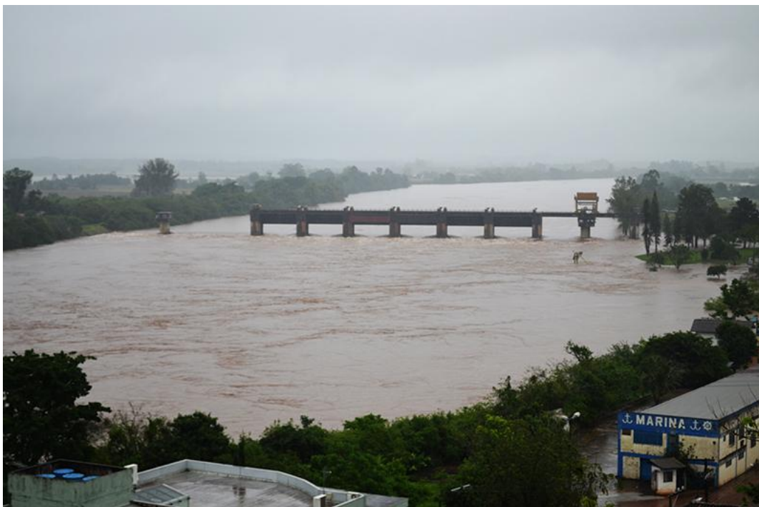
Figura 19 - Enchente do Rio Taquari, eclusa do município de Bom Retiro do Sul (outubro/2015). Fonte: Foto tirada por Juliano Beppler da Silva/Giro do Vale 30 .
