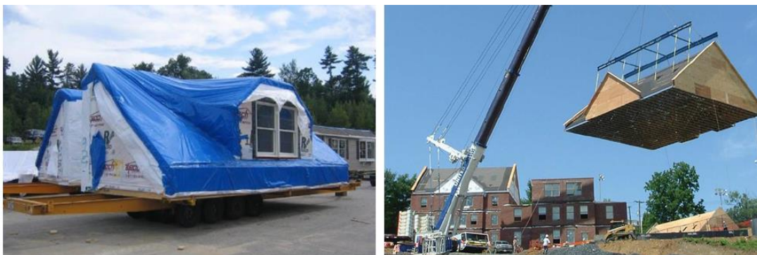
Figura 8: Telhado transportado separadamente do módulo e colocado no edifício.
