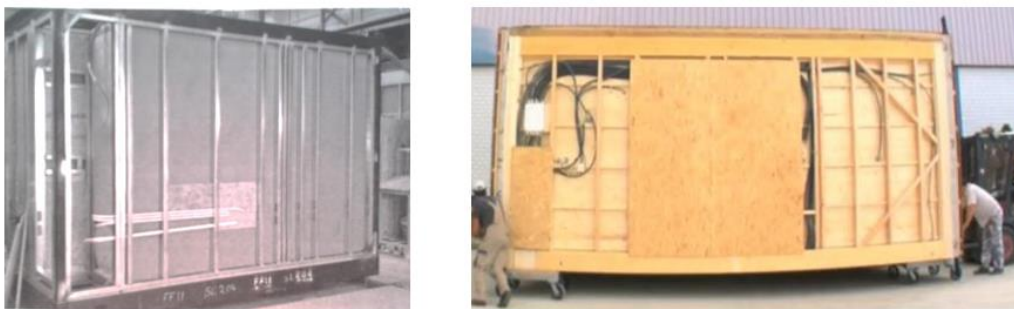
Figura 3: Exemplos de tubulação passadas nas paredes.
