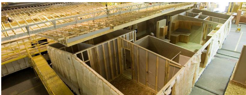
Figura 7: Telhado sendo colocado no módulo ainda na fábrica.
