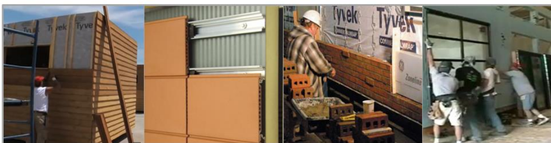
Figura 6: Exemplos de revestimentos em módulos com estrutura de madeira e aço.
