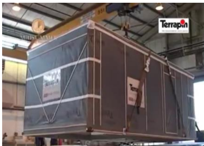
Figura 12: Módulo com proteção externa, preparado para transporte.
