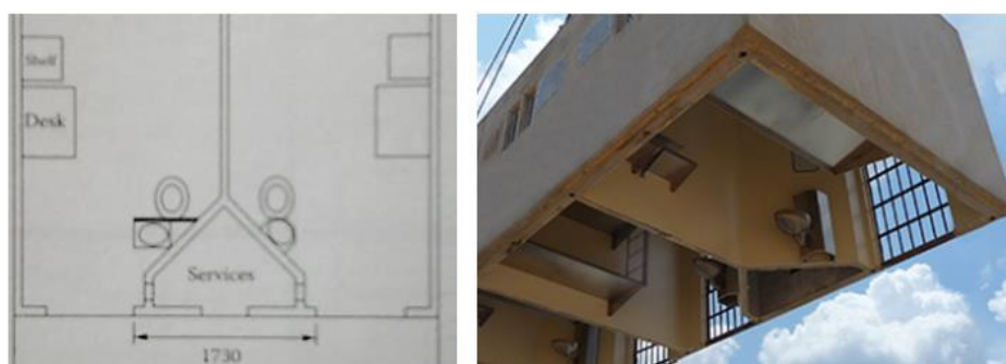
Figura 5: Exemplo de duto para tubulação hidráulica para banheiros em concreto.
