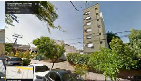
Figura 113: Edifício no mesmo bairro
