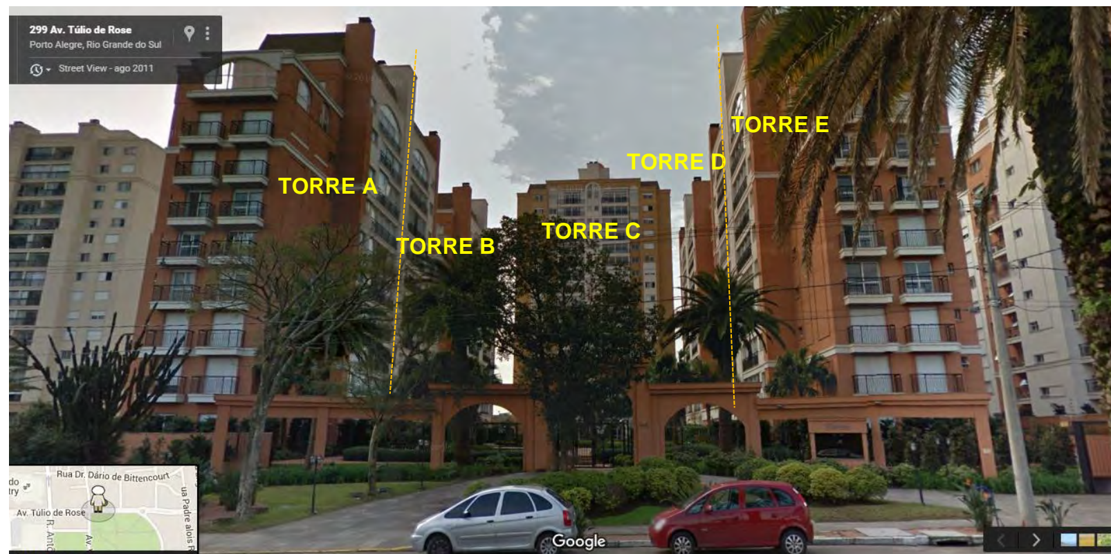
Figura 229: Fachadas dos edifícios do Condomínio Cipriani
