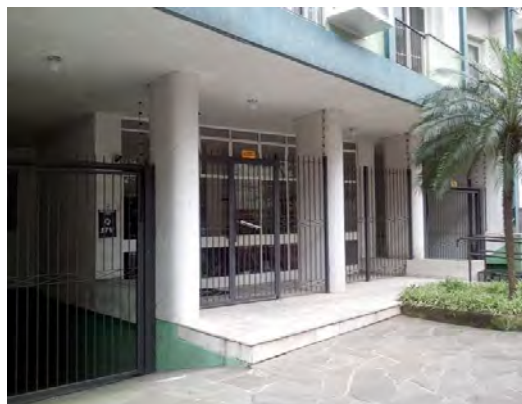
Figura 171: Imagem 10E - Calçada em frente ao Edifício Alegrete, na Praça Júlio de Castilhos
