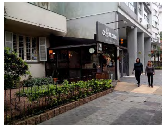
Figura 169: Imagem 10C – Calçada em frente ao Edifício Batovi, na Praça Júlio de Castílios
