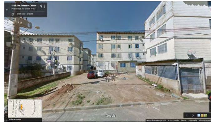
Figura 115: Foto atual de edifícios no mesmo conjunto habitacional na Zona Norte de Porto Alegre
