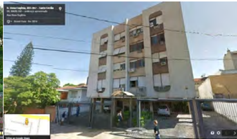
Figura 112: Edifício no mesmo bairro
