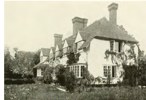
Figura 21: Fachada das mesmas edificações
