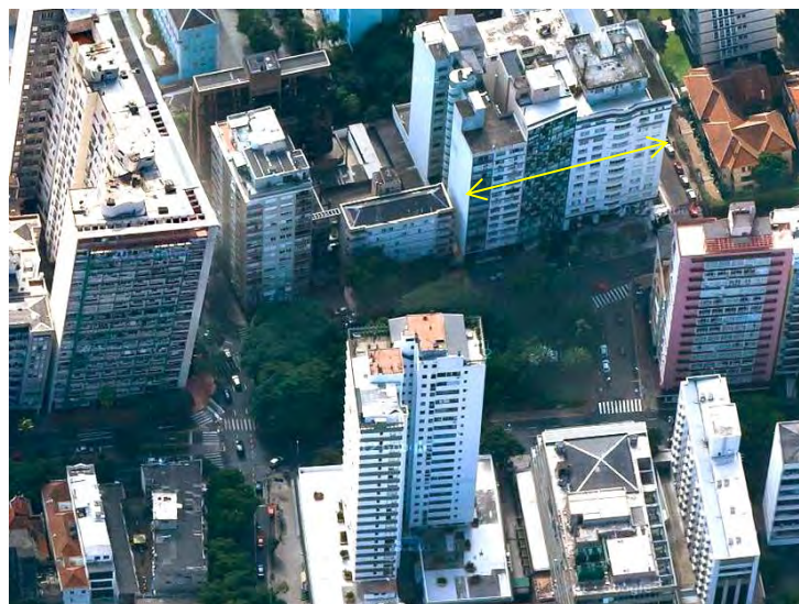
Figura 56: Imagem aérea da Praça Júlio de Castilhos em Porto Alegre. Em amarelo os três edifícios com fachadas contínuas da esquina com a Rua Jardim Cristofel
