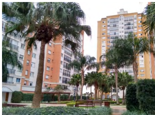
Figura 235: Vista das fachadas das Torres A, B, construções geminadas, e Torre C, a partir do interior do condomínio
