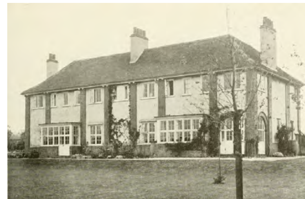
Figura 19: Fachada da mesma edificação
