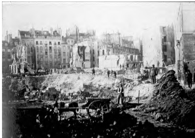
Figura 10: Obras de demolições para a abertura da Avenida da Ópera de Paris
