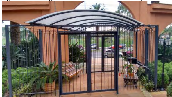
Figura 215: Imagem 13 – Portão de acesso de pedestres visto a partir da área interna do condomínio
