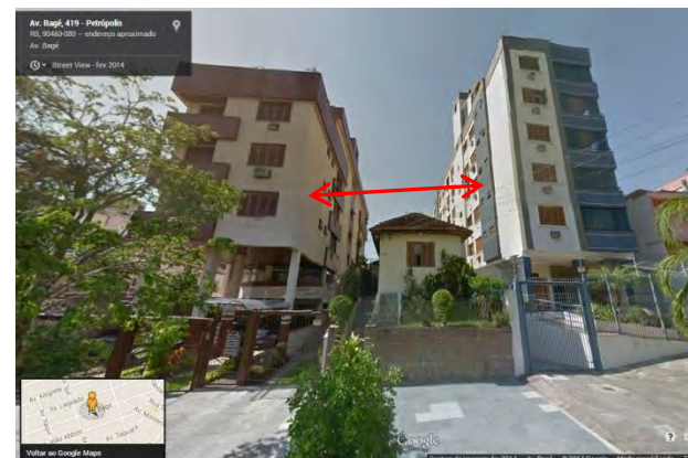
Figura 106: Foto atual de edificações assinaladas em amarelo na imagem ao lado
