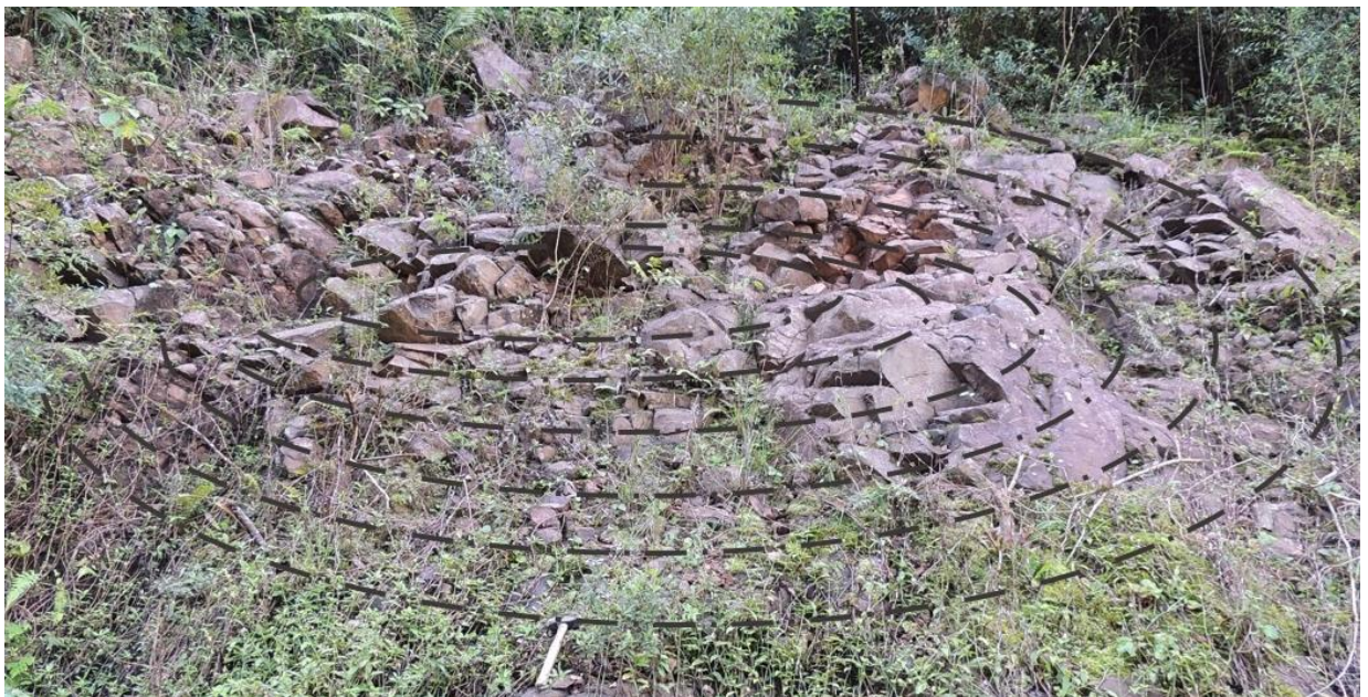
Figura 17: Estrutura em lobo no ponto 1.
