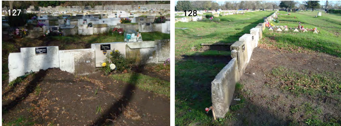
Figuras 127 e 128: Vista Vigas das Covas Rasas.
