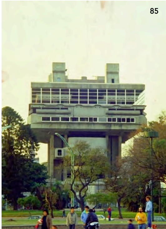
Figura 85: Biblioteca Nacional de Buenos Aires. Autor: Clorindo Testa, Francisco Bullrich e Alicia Cazzaniga. Fonte: Arquivo Digital FADU Buenos Aires.
