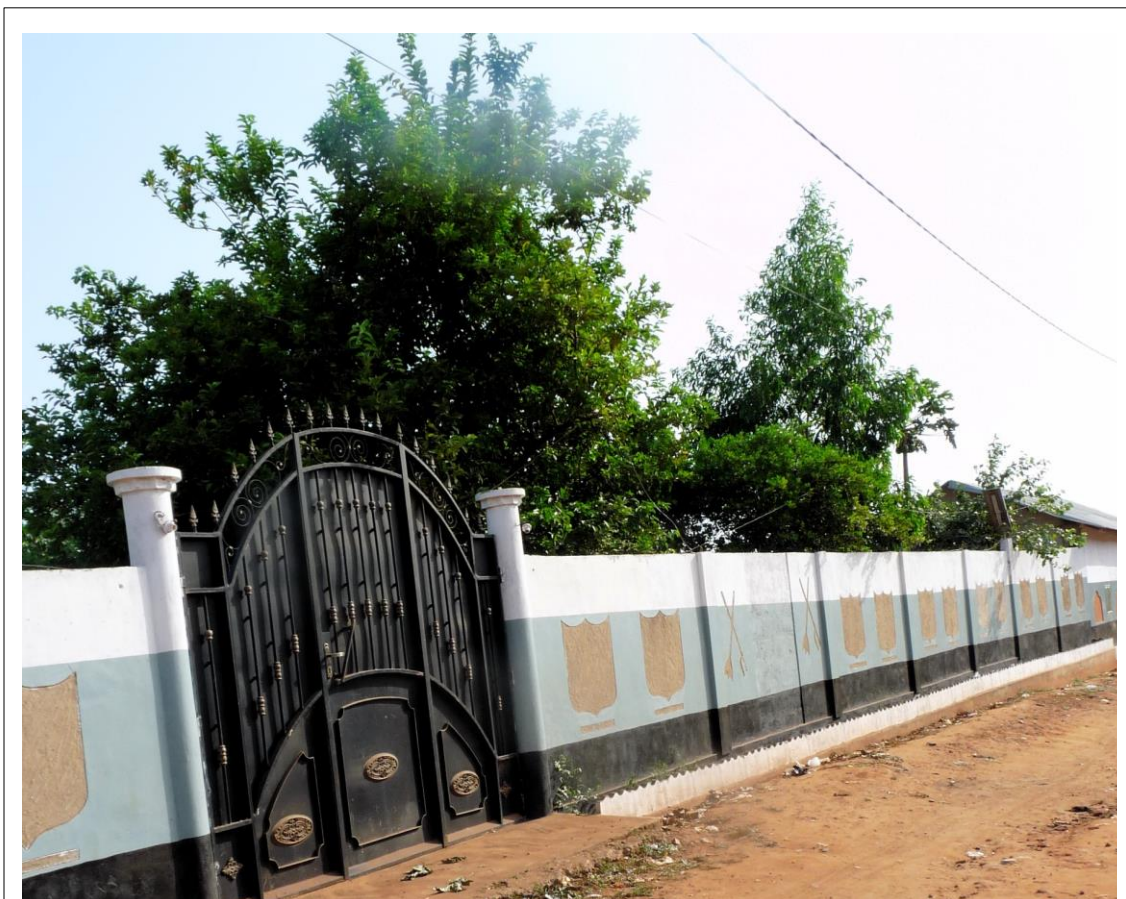
Figura 2: vista de Frente da casa de Daagbo Hounnon em Ouidah. O templo foi restaurado pela UNESCO em 2000.
