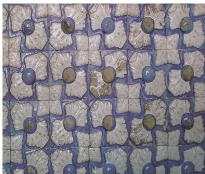
Figura 46 - Exemplo de queda do vidrado em partes salientes de azulejos cerâmicos do palácio da Pena, em Sintra, Portugal<sup>3</sup>.
