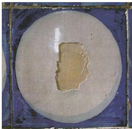
Figura 42 - Queda em mosaico em que o vidrado está completamente separado do biscoito<sup>3</sup>.
