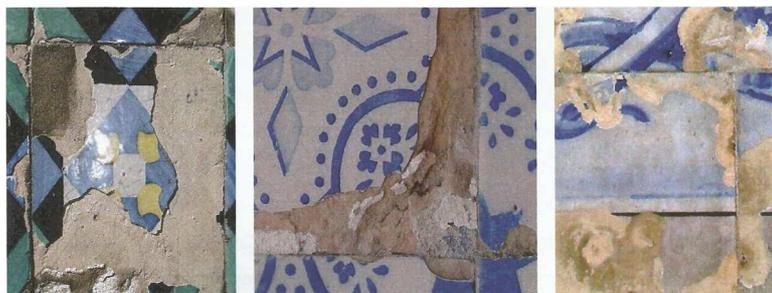
Figura 48 - Biscoito liso após a queda de vidrado comparado com biscoitos em processo de desagregação em lâminas ou por aerização mais ou menos fina em casos em que pode também estar em curso uma alteração por cristalização em sais solúveis<sup>3</sup>.
