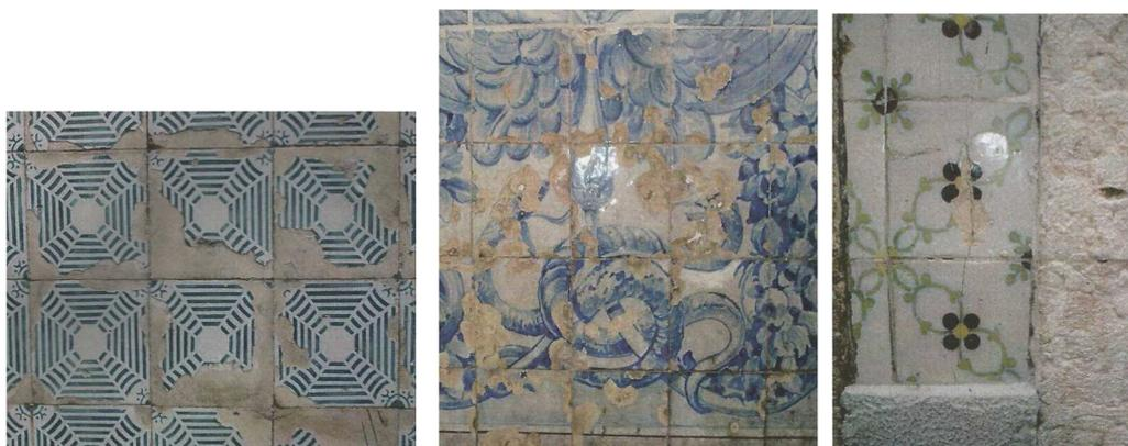
Figura 32 - Quedas de vidrado cujas morfologias características indicam possíveis origens em diferentes níveis de agressão e defeitos de aderência<sup>3</sup>.
