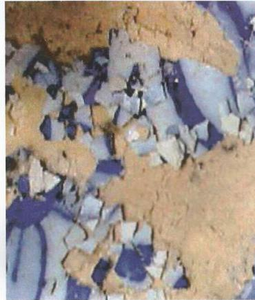
Figura 39 - Destacamento de mosaicos de vidro com craquelê do Tipo II<sup>3</sup>.
