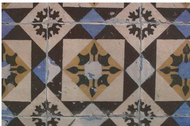
Figura 47 - Queda do vidrado afetando principalmente as áreas azuis<sup>3</sup>.
