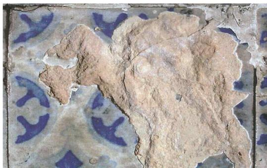
Figura 49 - Desagregação do biscoito, possivelmente provocada por cristalização de sais solúveis em zona ribeirinha (Largo de Corpo Santo, Lisboa)<sup>3</sup>.
