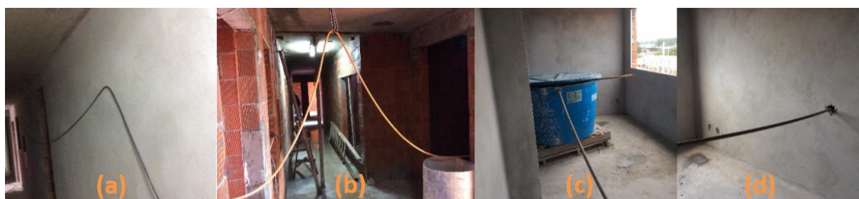
Figura 42: Perdas por making-do correspondentes à categoria instalações provisórias
