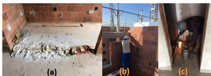
Figura 41: Perdas por making-do correspondentes à categoria ajuste de componentes
