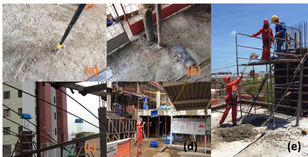
Figura 85: Perdas por making-do correspondentes à categoria de ajuste de componentes
