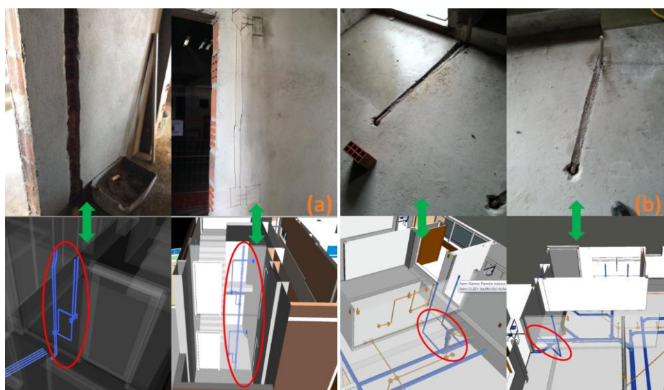
Figura 106: Utilização do BIM como apoio para a coordenação de tarefas nas reuniões de curto prazo
