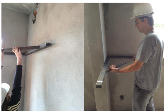
Figura 47: Verificações de qualidade executadas de forma pontual, utilizando ferramentas fornecidas no canteiro
