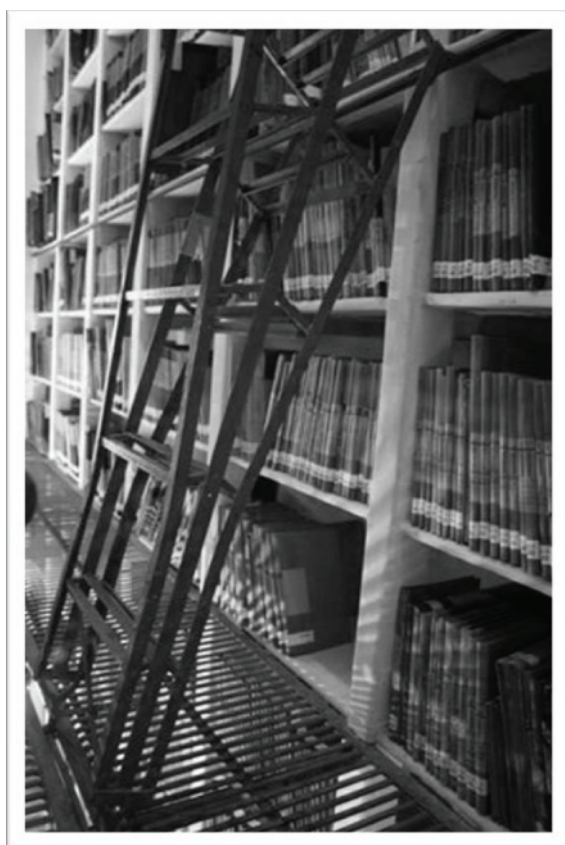
Figura 46: Foto interna Arquivo Público do Estado / Edifício 1ª fase – Estantes, Estrutura em ferro vazada e escada deslizante – 2006. Fonte: Fotografia de Ricardo Calovi – 2006.
