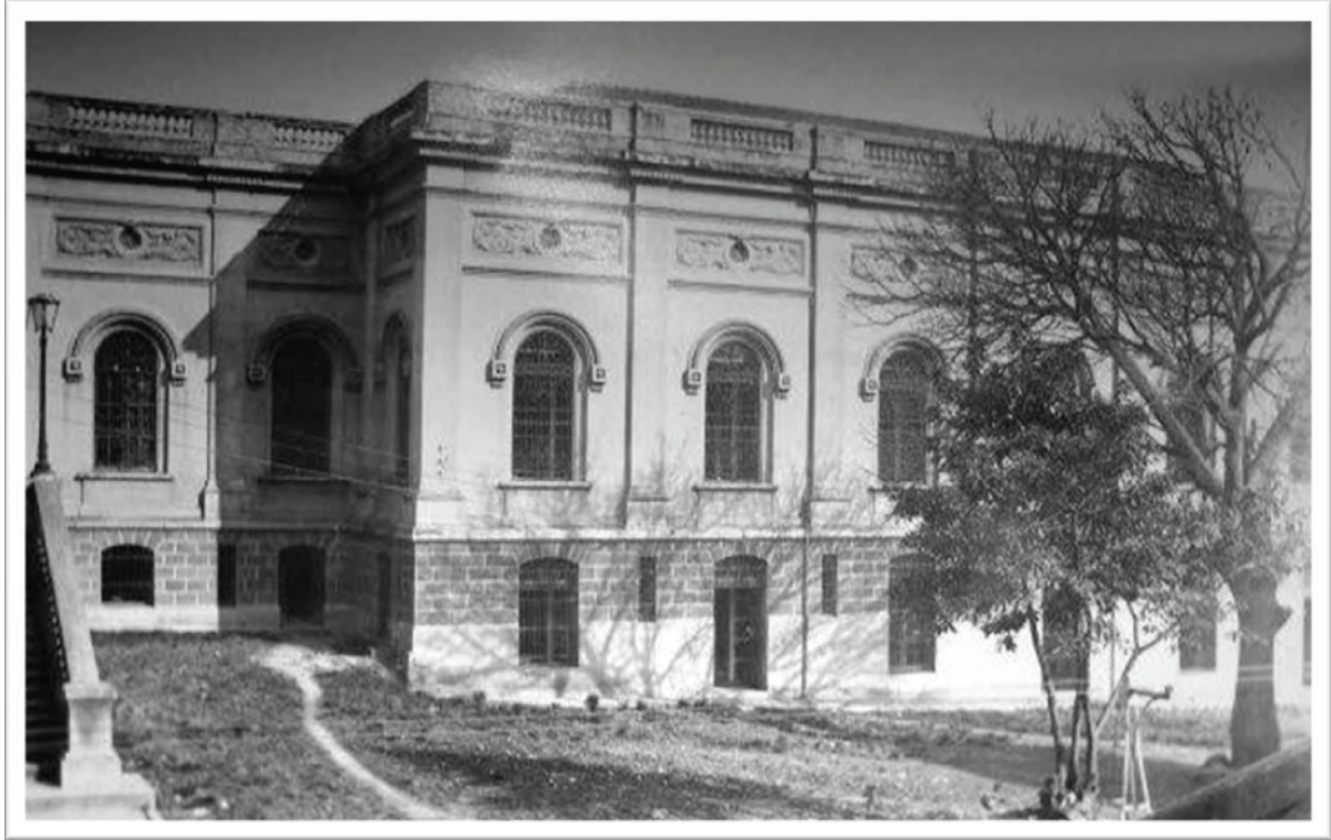
Figura 51: Foto da ala esquerda do Arquivo Público do Estado / Edifício 2ª fase – fachada principal (compartimento de ligação recuado) – por volta de 1920. Fonte: Família Prati em < www.fotosantigas.prati.com.br >, acessado em novembro de 2007.
