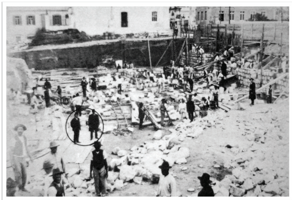
Figura 29: Foto do início das obras em 1909, quando demolidas as paredes e alicerces do projeto de Hebert de 1897. No círculo preto, de sobretudo e chapéu, está o Arquiteto Affonso Hebert, fiscal das obras, representando a Secretaria do Obras Públicas. Fonte: CORONA, Fernando. Palácios do Governo do Rio Grande do Sul: histórico de projetos, construção, obras de arte e seus autores. Porto Alegre: [s.n], 1973. p. 19.
