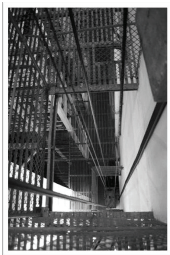
Figura 55: Foto interna Arquivo Público do Estado / Edifício 2ª fase – Estrutura em ferro vazada e escada de acesso aos pavimentos – 2006. Fonte: Fotografia de Ricardo Calovi – 2006.
