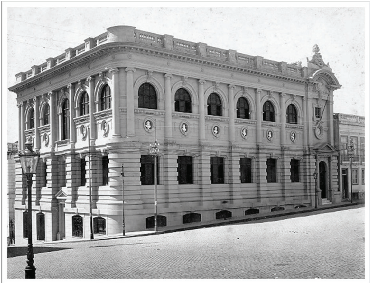
Figura 83: Foto da Biblioteca Pública do Estado | 2ª fase – obra concluída – 1922. Fonte: Álbum de inauguração da Biblioteca Pública, 1922, sem página.
