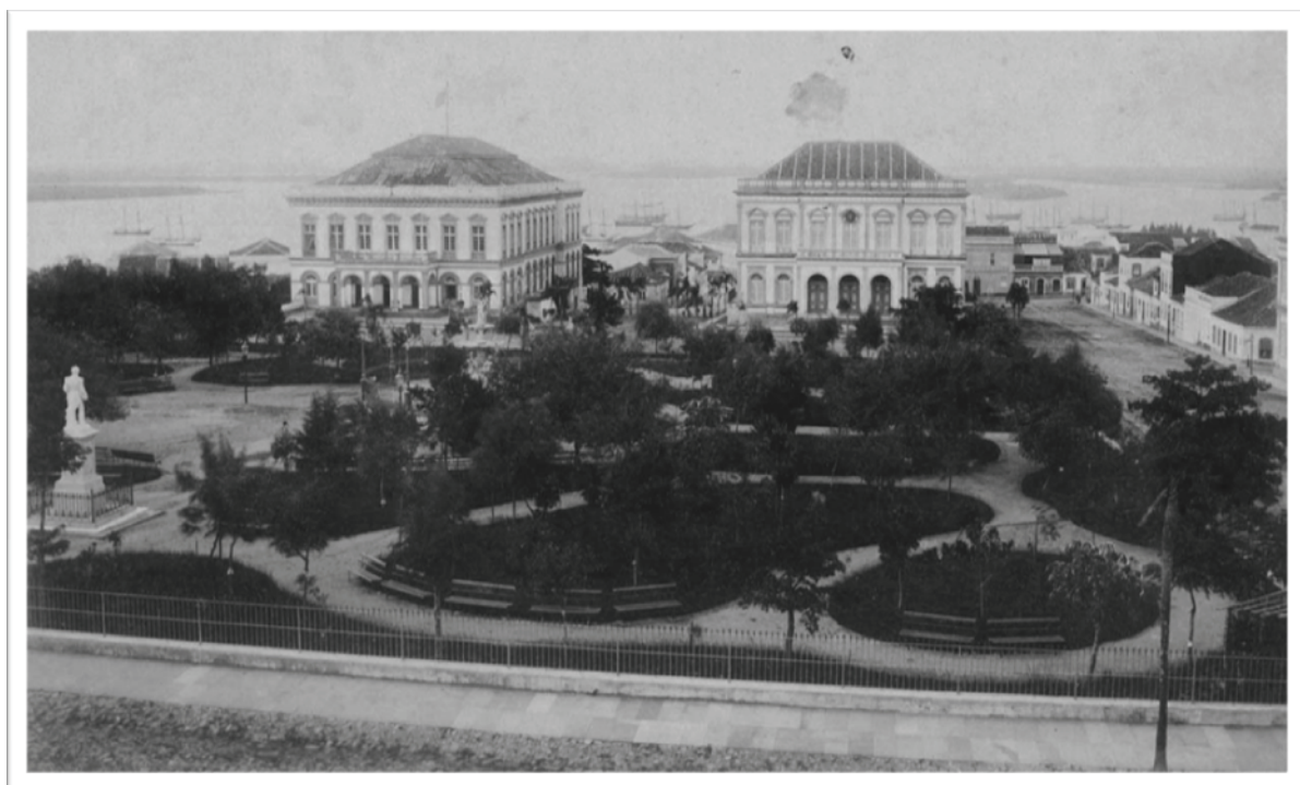
Figura 13: Foto dos edifícios gêmeos projetados por Philip Von Normann (Teatro São Pedro e Palácio da Justiça) junto a Praça Marechal Deodoro – por volta de 1890. Fonte: Acervo digital do Projeto Monumenta.
