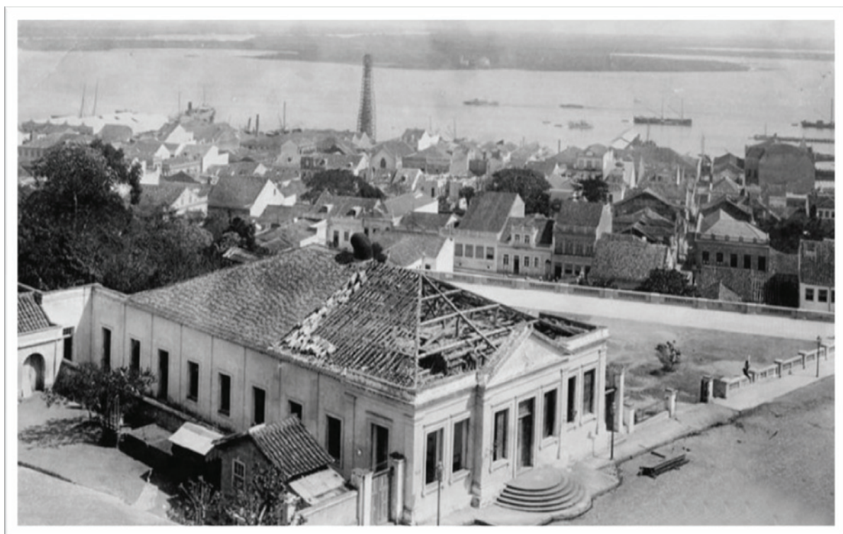
Figura 43: Foto do Prédio da Bailante, pertencente à Companhia Hidráulica Porto Alegrense, com o muro a ser substituído citado em seguida ao fundo – por volta de 1900. Fonte: Família Prati em < www.fotosantigas.prati.com.br >, acessado em janeiro de 2008.
