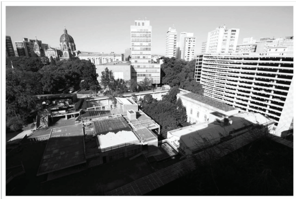
Figura 59: Edifícios do Arquivo Público do Estado do Rio Grande do Sul – vista aérea a partir do hotel em frente – 2008. Fonte: Fotografia de Ricardo Calovi – 2008.
