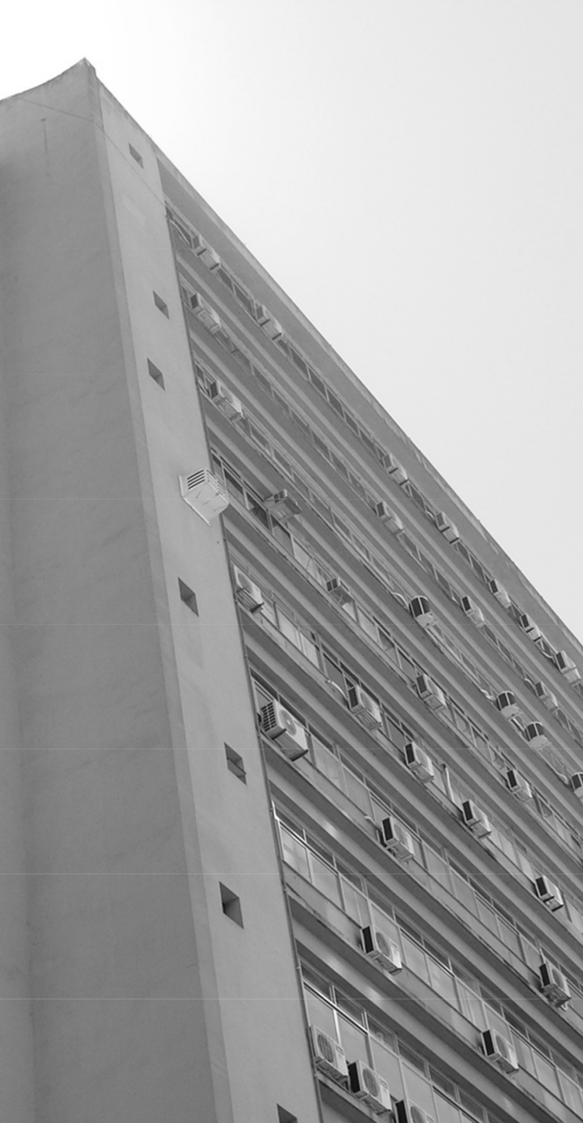
Foto: Edifício das Diretorias, Florianópolis, 2014 [Engenheiro Domingos Trindade, 1961]
