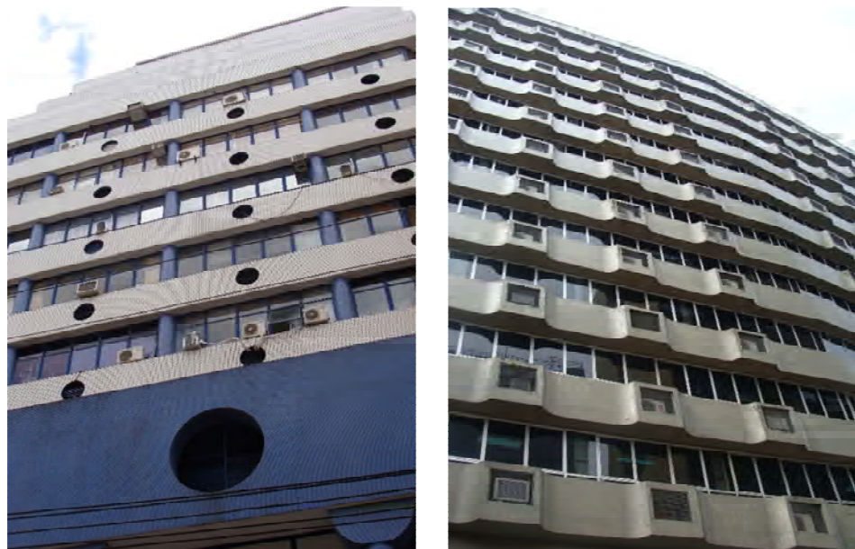
Figura 3-22 a e b Aberturas e vedações transparentes aplicadas a 50% da área total de fachada.
