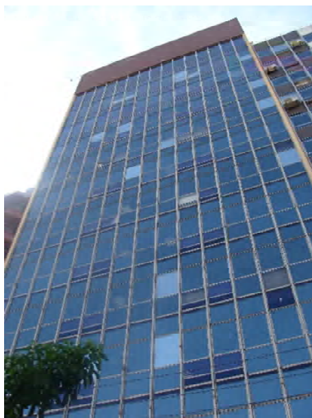
Figura 3-29 (Esquerda) Aberturas e vedações transparentes aplicadas a 100% da área total de fachada. Edifício na Avenida Hercílio Luz (2015).
