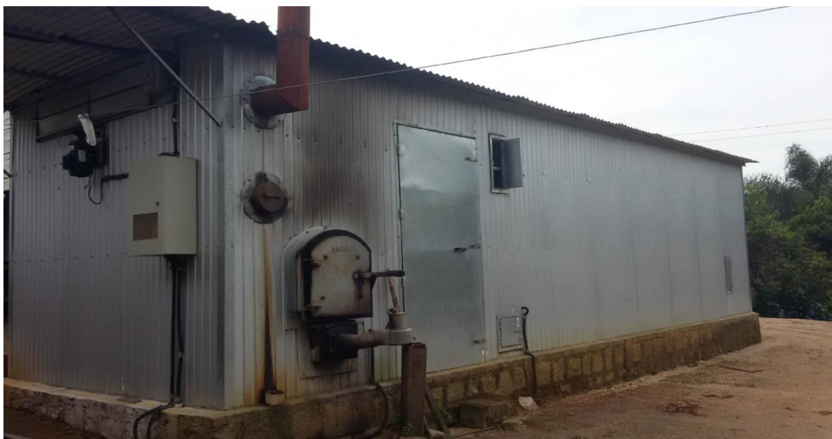
Figura 40 – Estufa elétrica utilizada para fazer a secagem das folhas de tabaco. Fonte: Trabalho de Campo/autor.
