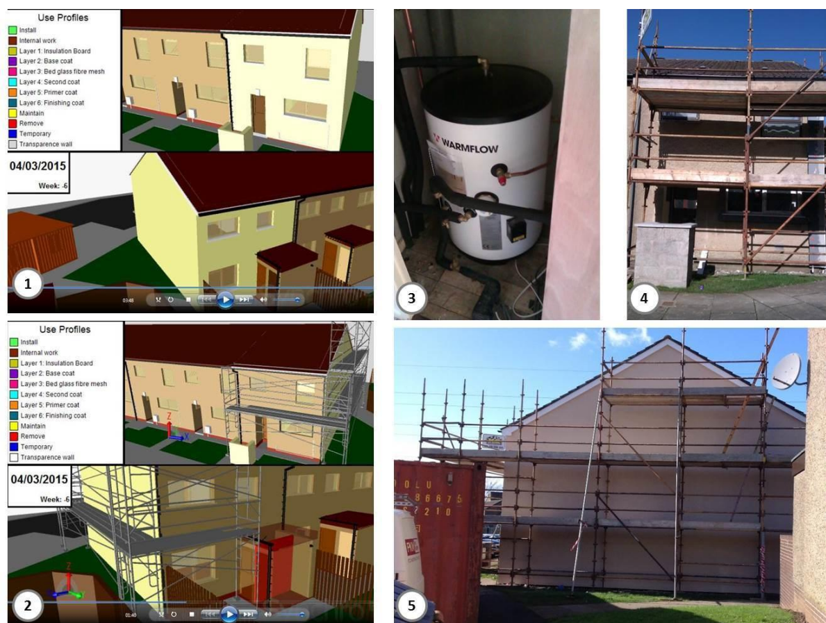
Figura 26: Observações realizadas na visita à obra em 04/03/2015 (visita 6).
