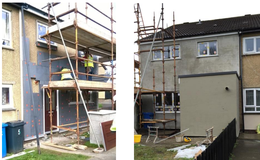
Figura 29: Retirada dos tubos condutores de água, comuns às habitações 5 e 6, para execução do isolamento das paredes externas.
