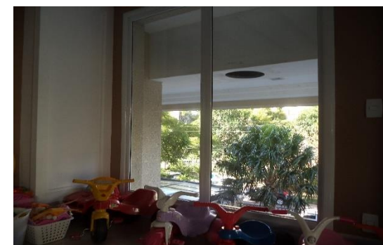
Figura 86: Grande esquadria no kids place do edifício 01. Fonte: Camilla Abreu, 2015.
