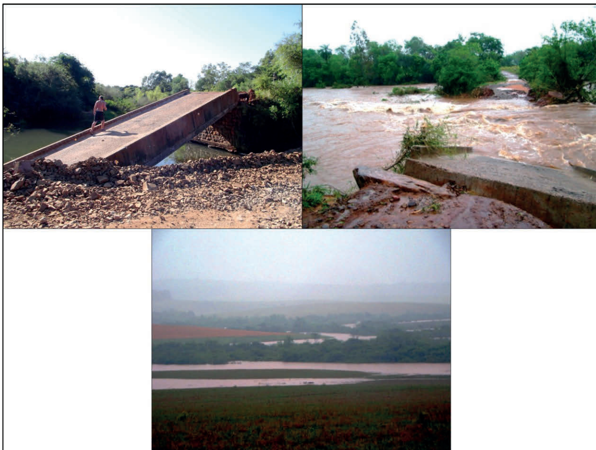
Figura 66 – Ponte sobre o arroio Taquari, na estrada entre São Francisco de Assis e o distrito de Vila Kramer, derrubada no/s pico/s de cheia/s ocorridos no final do ano de 2014 (acima/esquerda) e durante a cheia de outubro de 2015 (acima/direita). Várzea do arroio Miracatu inundada pelo evento de outubro de 2015 (abaixo/centro). Fotos: Andrey Luís Binda (2015a) e Nossa Gente Assisense 99 (2015b e c).
