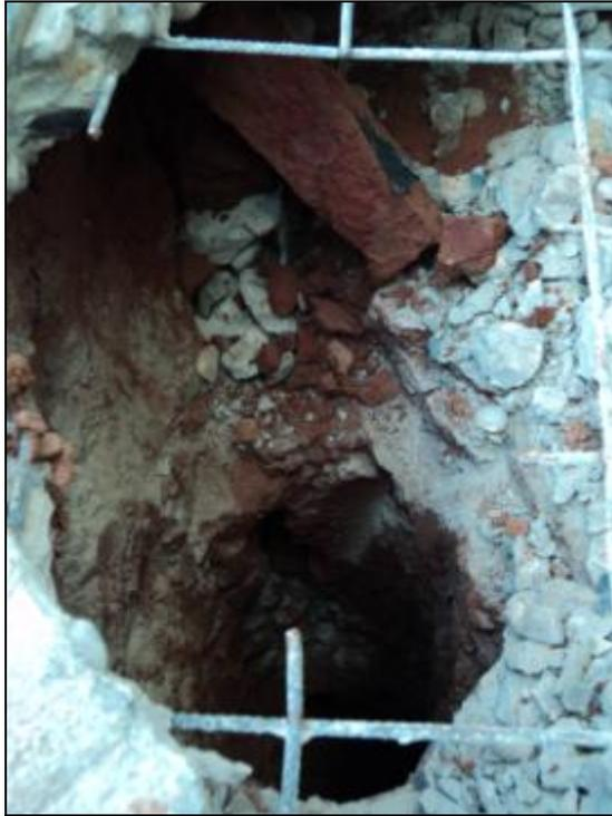
Figura 3. Espaços vazios sob o piso de concreto e sondagem a trado.
