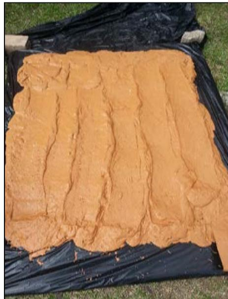
Figura 13. Espalhamento e regularização da camada.
