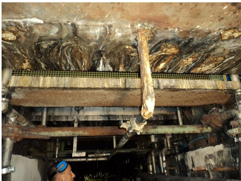
Figura 2. Infiltrações visíveis abaixo do equipamento.
