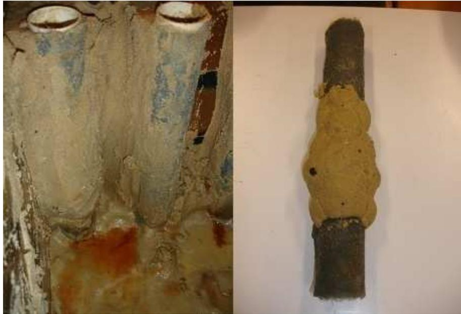
Figura 4.17: Cimentação provocada pelo  $\text{CaCO}_3$ .
