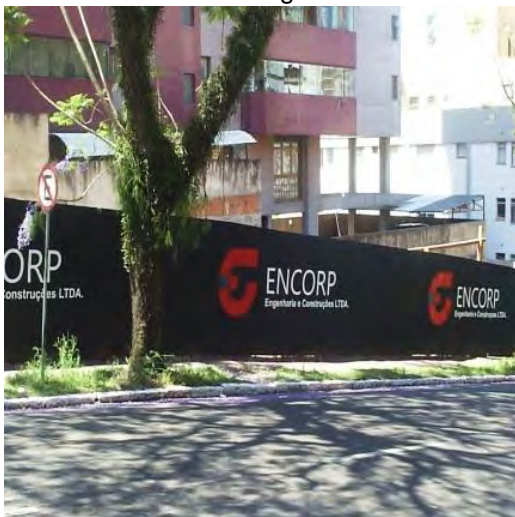
FIGURA 8- Tapume em empreendimento imobiliário em Porto Alegre
