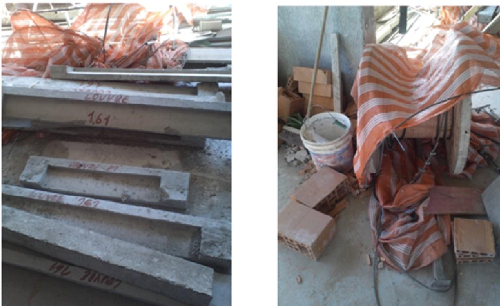
Figura 46- Improvisação no armazenamento de pré-moldados e blocos
