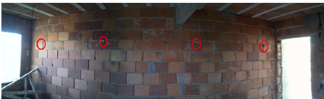
Figura 109- Posicionamento de mestras na quantidade e espaçamento ideal
