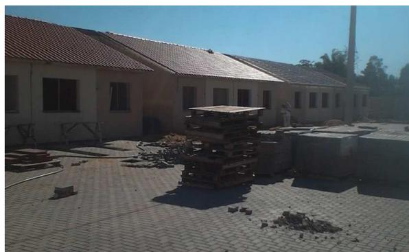
Figura 94- Execução do calçamento impediu que o transporte de sacos de gesso fosse realizado pelo caminhão
