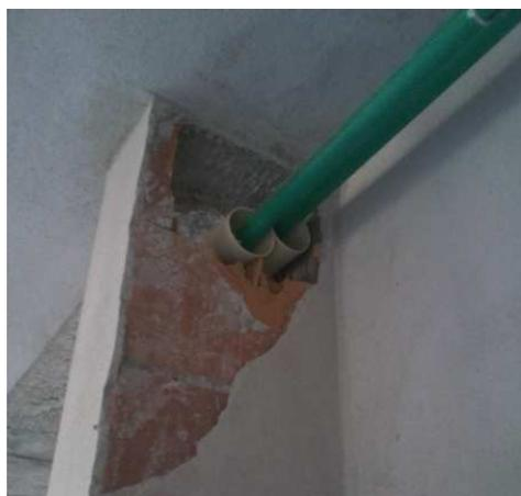
Figura 74- Instalações suspensas de água fria posicionada posterior à conclusão da alvenaria
