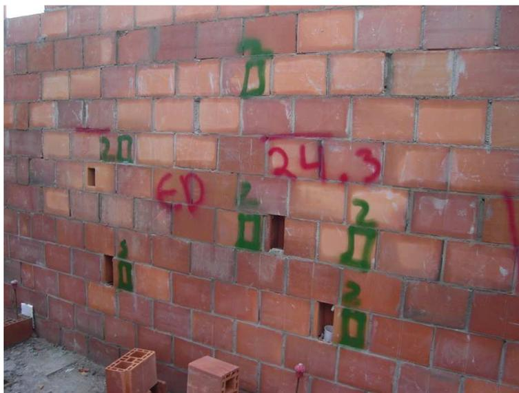
Figura 19- Falta de balanceamento entre equipe elétrica e alvenaria gerou arremates e retrabalhos
