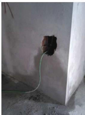
Figura 85- Buraco aberto na parede para passar mangueira usada como ponto de água
