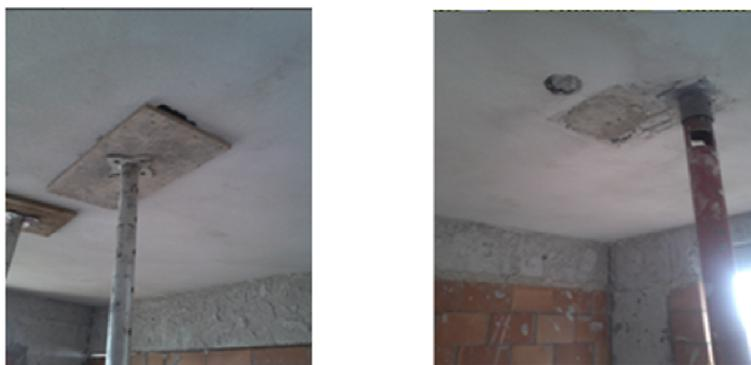
Figura 77- Revestimento de teto realizado antes da retirada de fôrmas (esquerda) e da estrutura de suporte a linha de vida dos contramarcos (direita).
