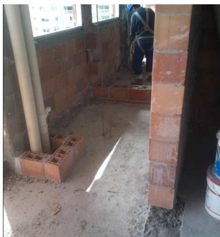
Figura 56- Parede do *shafts* esperando ser concluída
