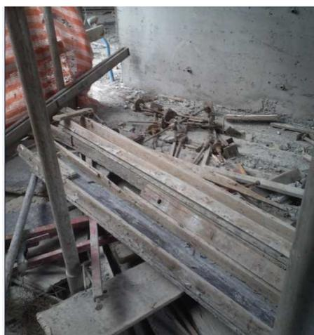
Figura 51 – Materiais armazenados desordenadamente
