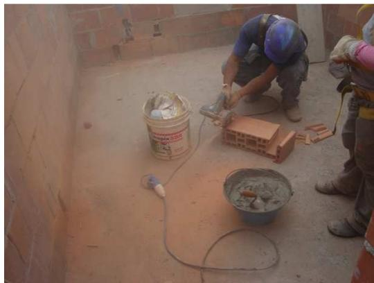
Figura 27- Ausência de bancada de trabalho para ajuste de blocos nos pavimentos
