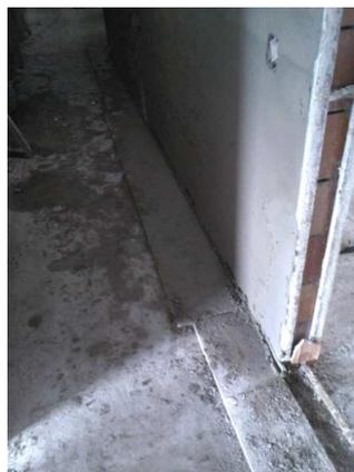
Figura 82- Tábuas de madeira substituindo lonas apropriadas para o reaproveitamento de argamassa
