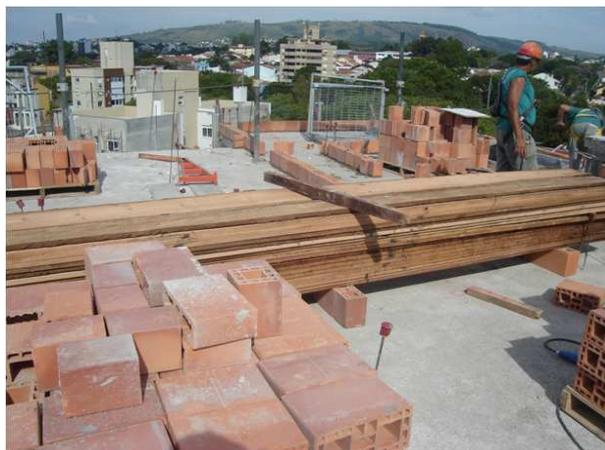
Figura 29- Madeiras que seriam usadas na proteção de periferia interferindo na movimentação das equipes
