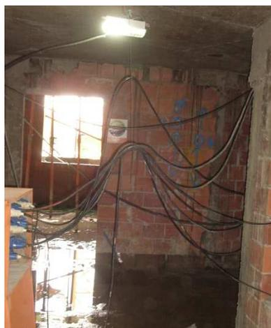
Figura 28- Improvisação para suspender fiação de instalação elétrica
