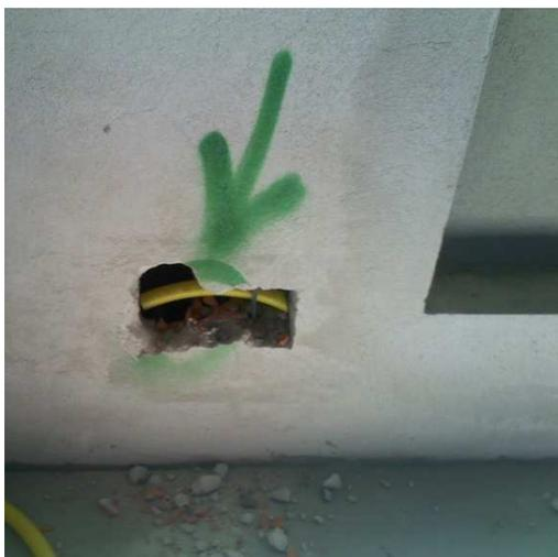
Figura 81- Parede revestida mesmo com caixas elétricas em posição incorreta
