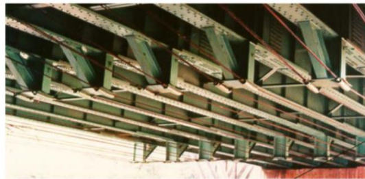
Figura 1.1 Protensão Externa de reforço Ponte Condut (Indonésia)
