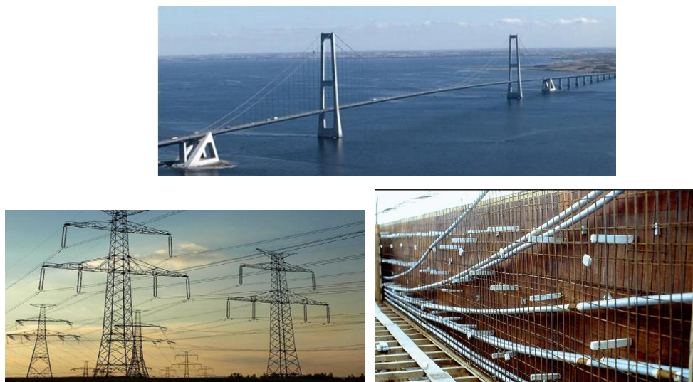
Figura 3.1 Pontes Suspensas, Torres de Alta tensão e Vigas Protendidas
