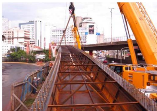
Figura 1.9 Içamento da viga metálica do viaduto na Av. Júlio de Castilhos (Porto Alegre)
