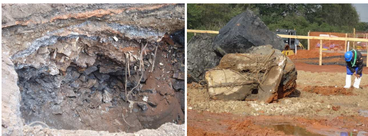
Figura 40: Aterro de resíduos industriais presente no subsolo do local de construção dos novos prédios: necessidade de remoção e execução de reaterro compactado
