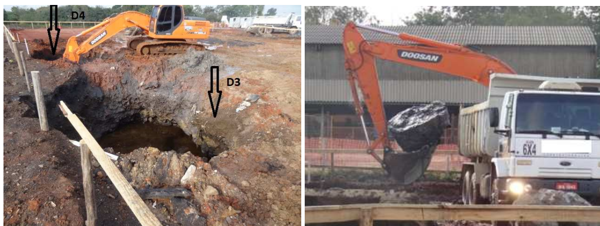
Figura 41: Teste prático para estabelecimento de um índice de produtividade da escavadeira no tipo de material existente no subsolo da unidade
