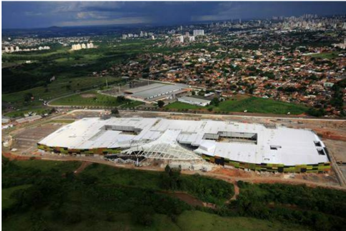
Figura 4- Shopping Passeio das águas visto aérea durante a construção. Fonte: site: http://www.skyscrapercity.com/showthread.php?t=679616 . Acesso em 21 de março 2015.
