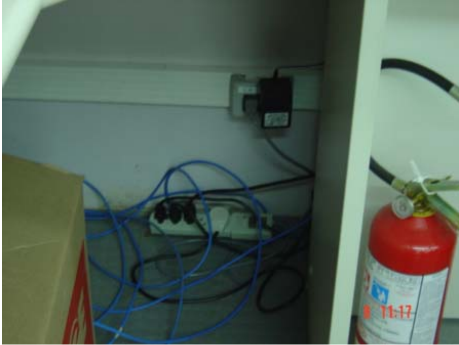
Figura 12 – Ligações simultâneas de mais de um aparelho na tomada
