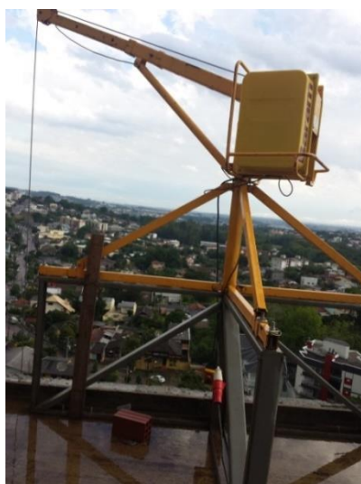
Figura 32 – Minigrua apoiada em estrutura exigida pela fiscalização na obra 11
