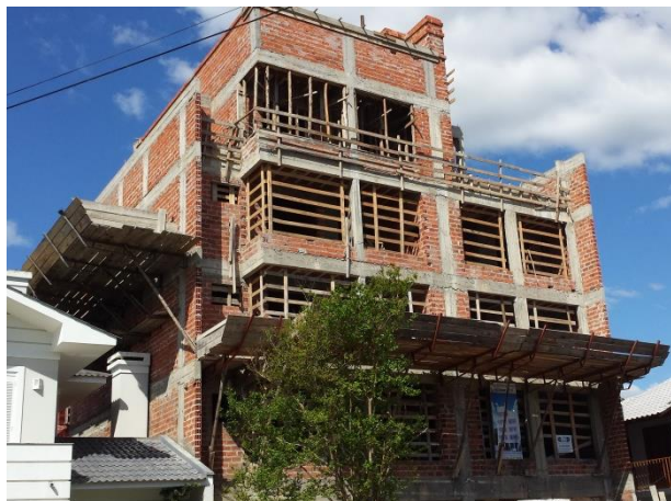
Figura 26 – Plataforma principal contornando a edificação na obra 04
