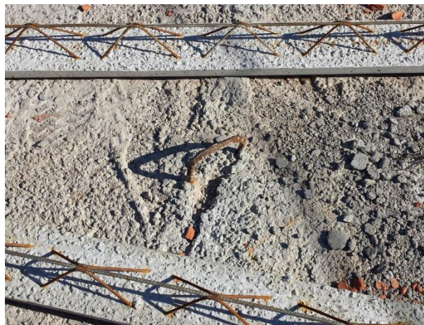
Figura 29 – Gancho concretado na laje da cobertura na obra 9
