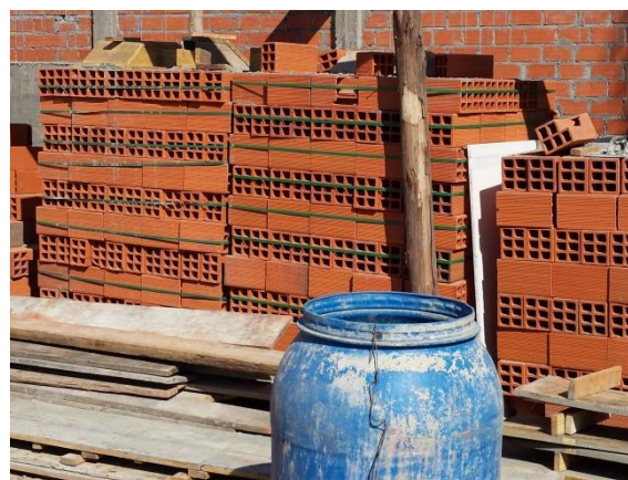
Figura 7 – Estocagem de material na obra 01
