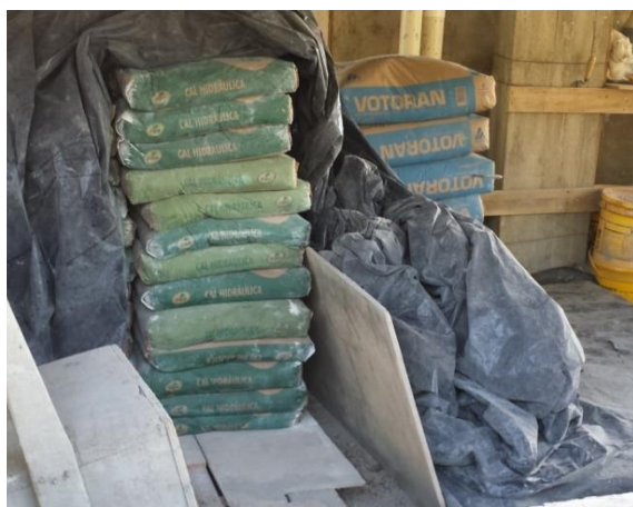
Figura 6 – Estocagem de material na obra 05
