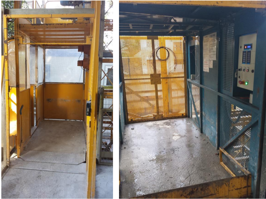
Figura 30 e Figura 31 – Plataforma dos elevadores analisados nas obras 05 e 11 respectivamente
