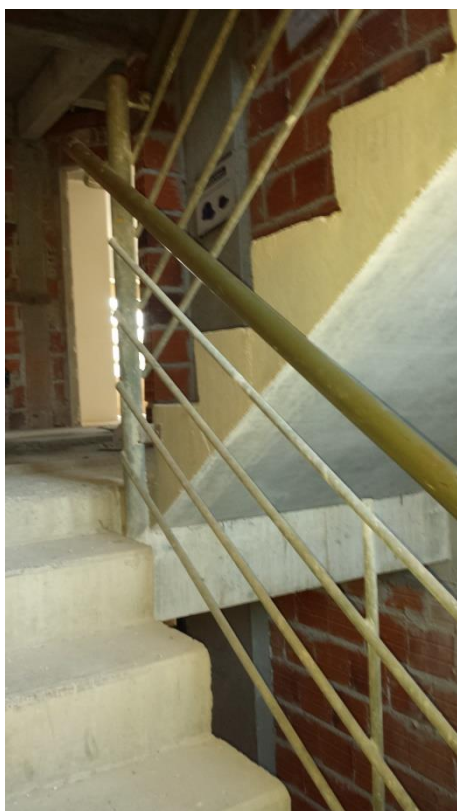
Figura 19 – Corrimão Metálico na obra 05
