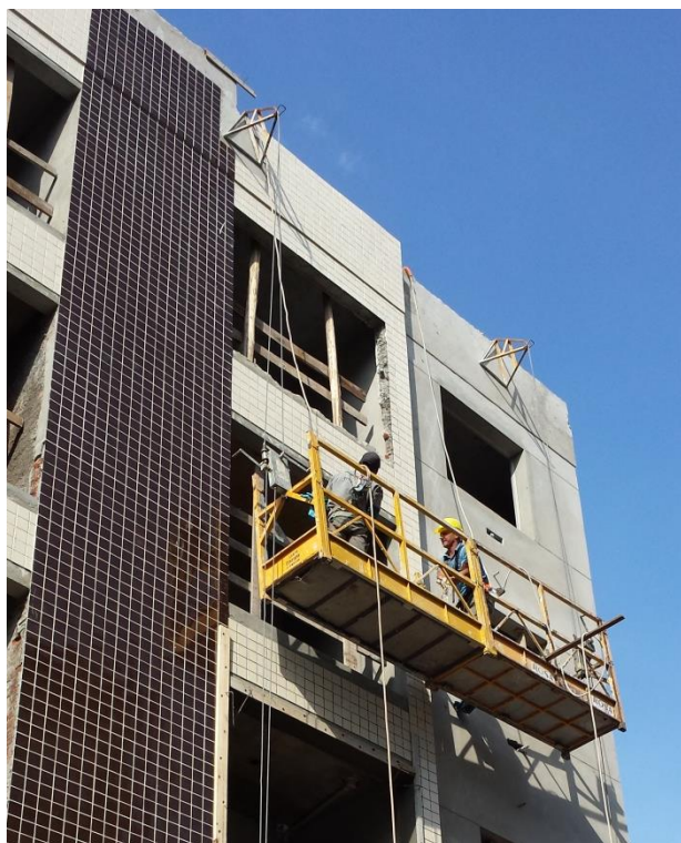
Figuras 27 e 28 – Exemplo de andaime suspenso mecânico analisado na obra 05 e obra 03 respectivamente.
