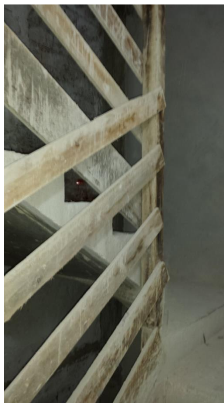
Figura 20 – Corrimão de Madeira na obra 03
