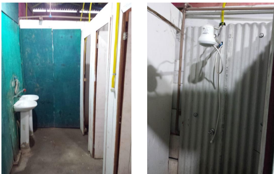
Figura 13 – Conjunto banheiro com chuveiro e vaso sanitário na obra 10
