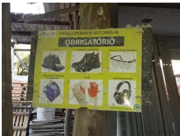
Figura 10 – (a) Sinalização de uso obrigatório de EPI na obra 09
