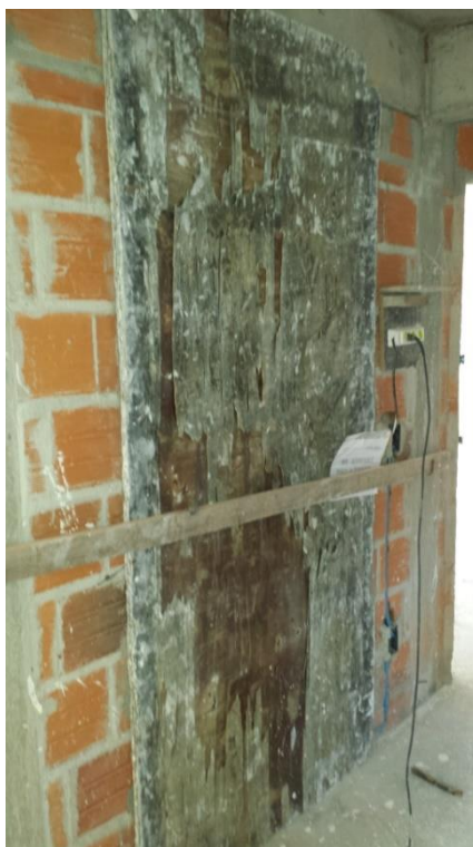
Figura 23 – Fechamento do poço do elevador na obra 05
