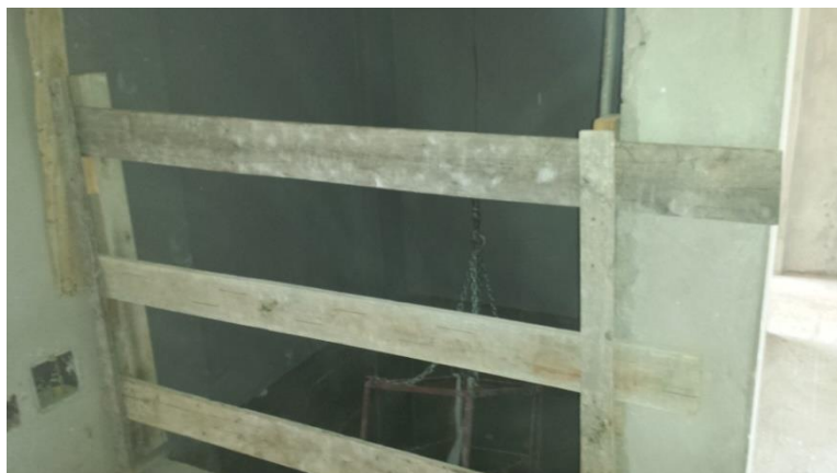
Figura 24 – Fechamento com guarda corpo removível na obra 01
