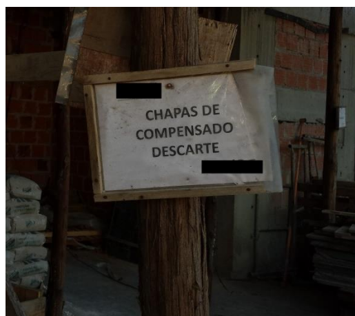
Figura 9 – Separação do entulho na obra 05
