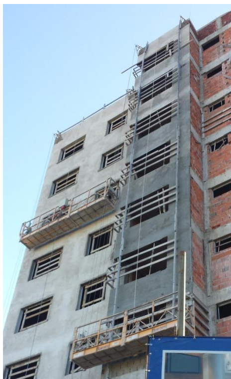
Figuras 27 e 28 – Exemplo de andaime suspenso mecânico analisado na obra 05 e obra 03 respectivamente.
