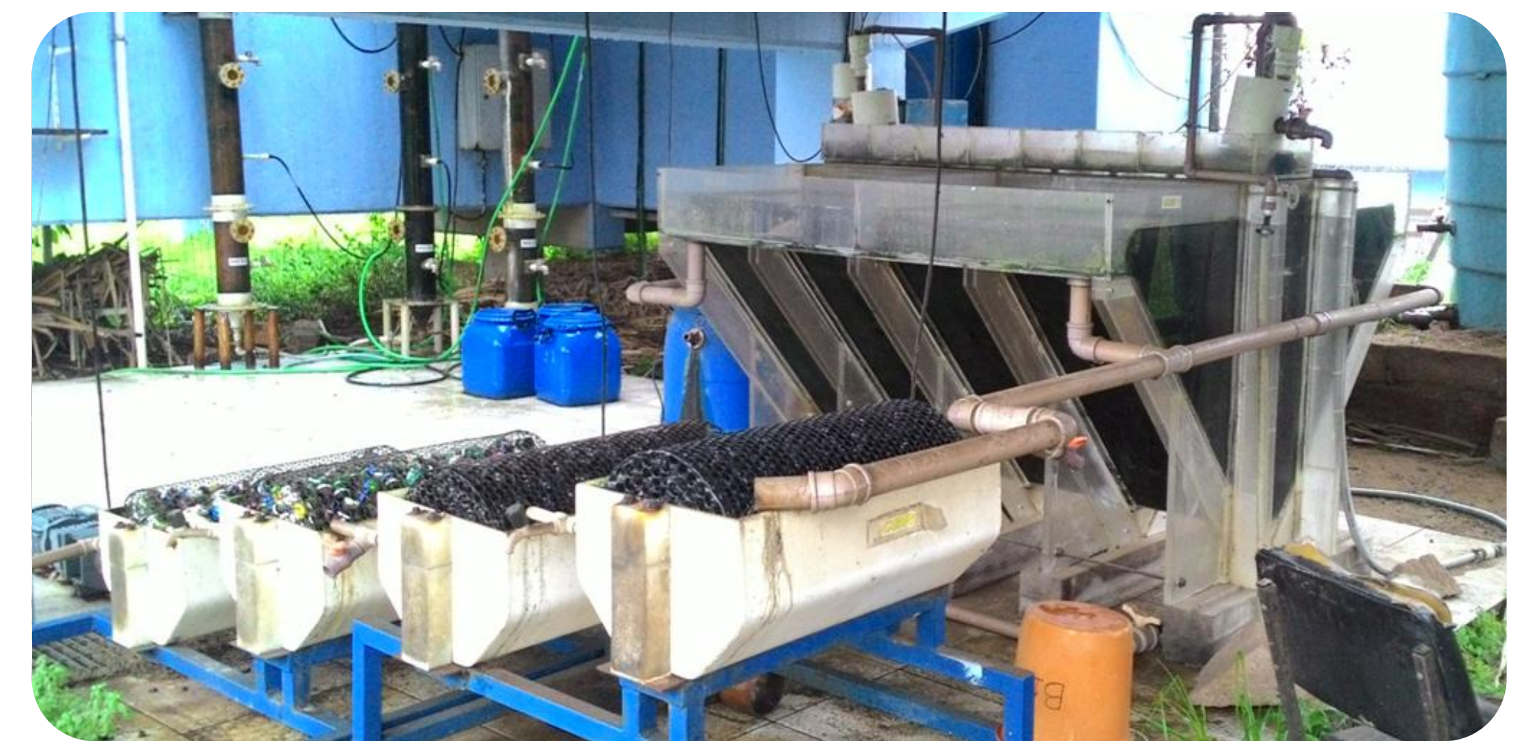
Figura 1 – UASB 1 (esquerda ao fundo), UASB 2 (direita ao fundo) e CBR (à frente).
