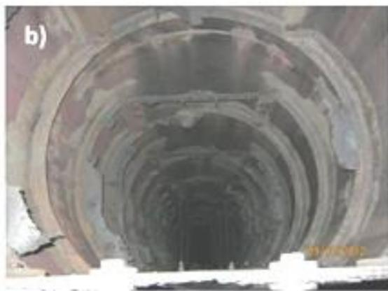
Fig. 2: O desaparecimento de partes do equipamento confirma corrosão severa.
