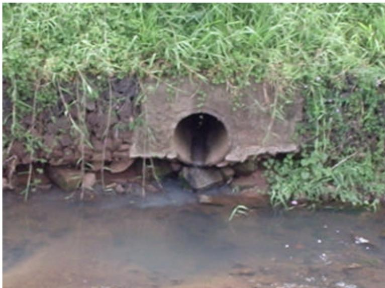
**Fotografia 41 - Esgoto doméstico sendo lançado diretamente no arroio Grande, Nova Hartz**
