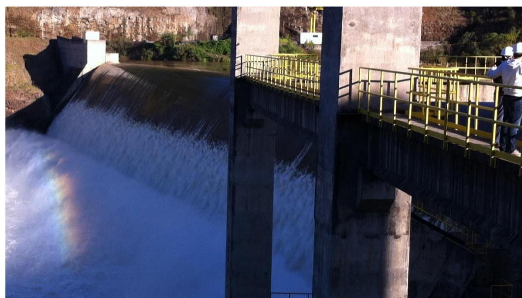
Vertedouro em Degraus da Usina Hidrelétrica 14 de Julho sob escoamento aerado.
