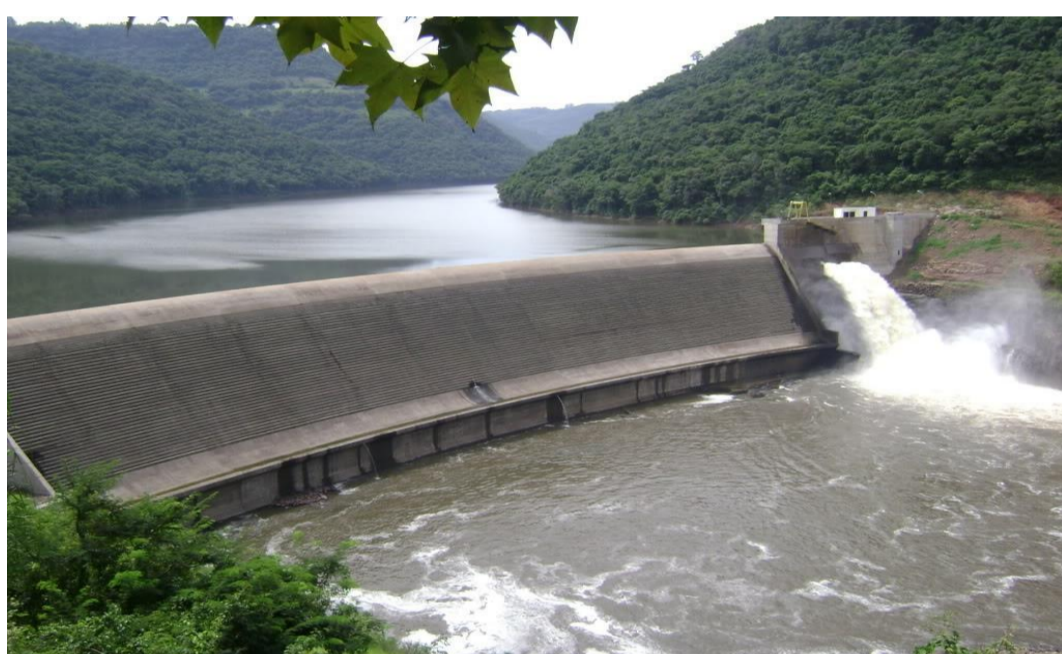
Vertedouro em Degraus da Usina hidrelétrica Castro Alves.
