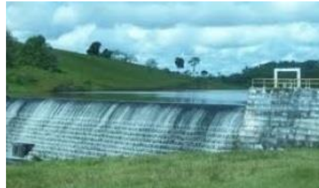
Vertedouro em Degraus da Barragem Rio da Dona, Stº Antônio de Jesus/BA.
