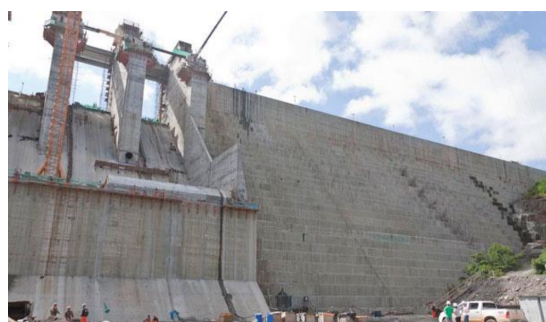
Vertedouro em Degraus da Usina Hidrelétrica Mauá.
