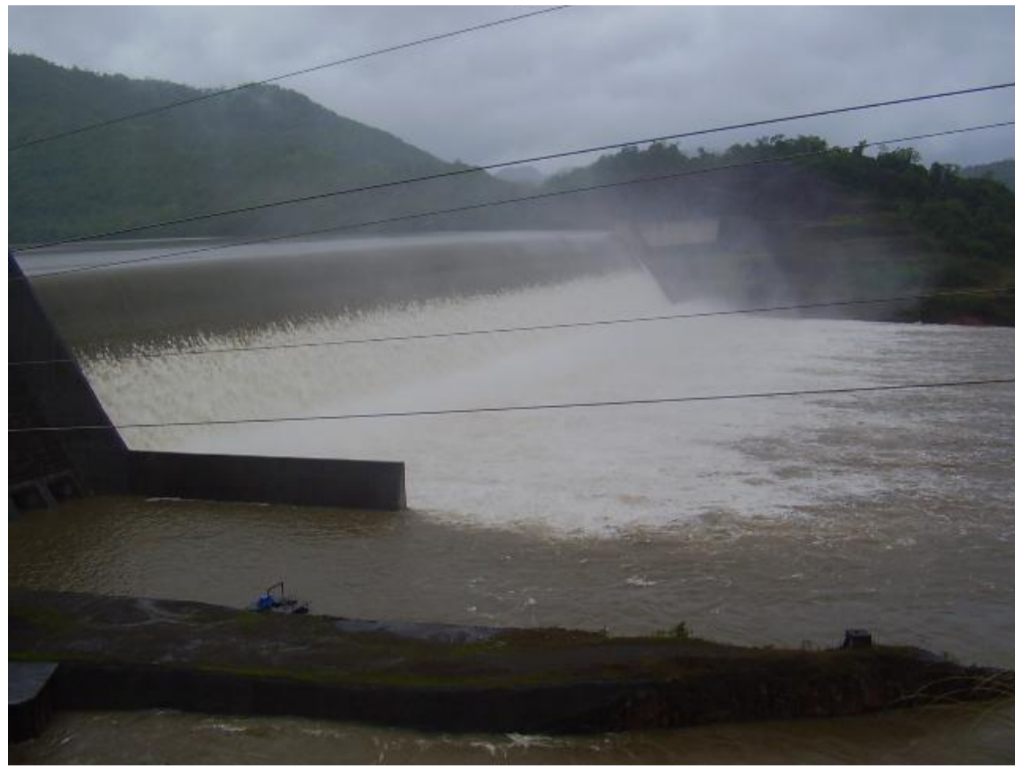
Vertedouro em Degraus da Barragem Dona Francisca - Agudo/RS
