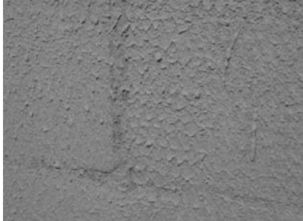
Figura 5: superfície com aplicação de chapisco rolado (CEOTTO et al., 2005)
