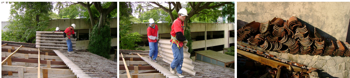
Figura 51: Telha cimentícia (componente) e telha cerâmica (componente): demolição D (Empresa 07)
