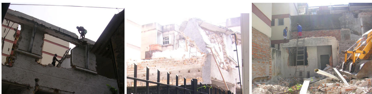
Figura 53: Tijolo (componente): demolição B (Empresa 05)
