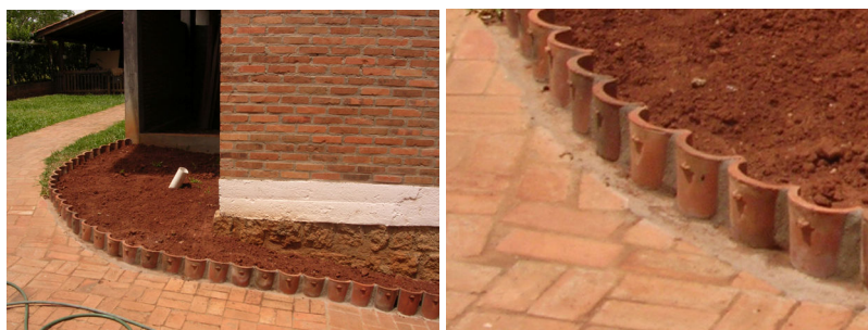
Figura 78: Reaproveitamento telha cerâmica e tijolos (componentes) para paisagismo (Projetista 03)
