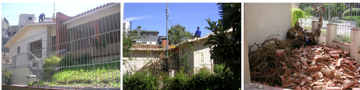
Figura 50: Telha cerâmica (material amorfo): demolição C (Empresa 05)
