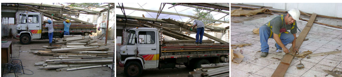
Figura 44: Estrutura do telhado: demolição E (Empresa 08)
