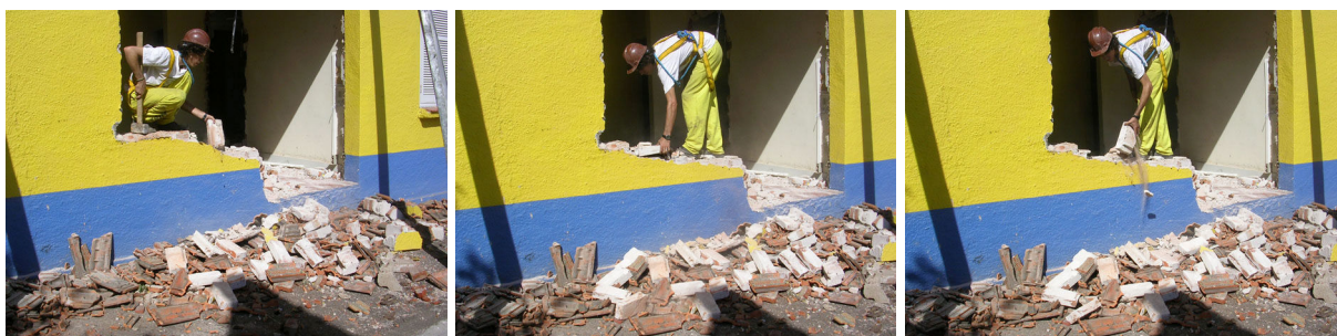
Figura 54: Tijolo (componente): demolição D (Empresa 07)
