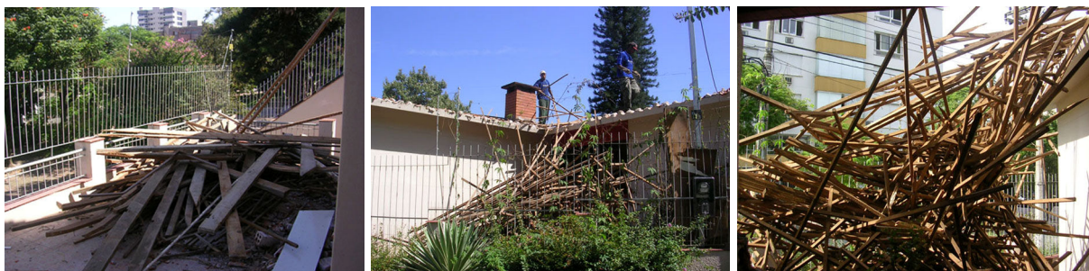
Figura 46: Madeira reuso (E) e madeira incineração (D), demolição C (Empresa 05)
