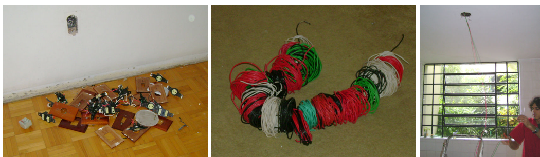
Figura 65: Fios retirados reuso como material elaborado (Empresa demolidora 08)
