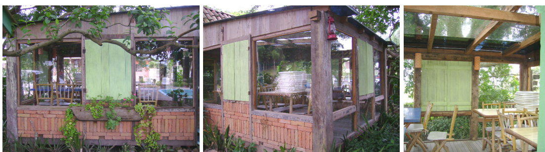
Figura 76: Edifício projetado com a mesma estrutura que edifício anterior
