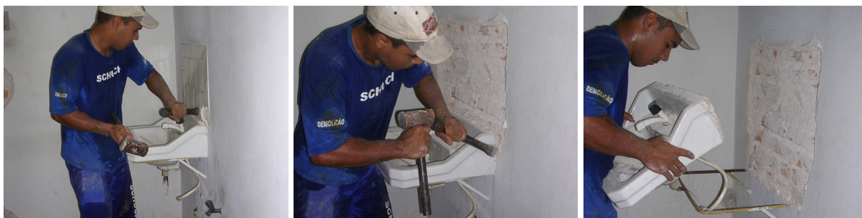
Figura 60: Retirada cuba: componente (Demolição A)
