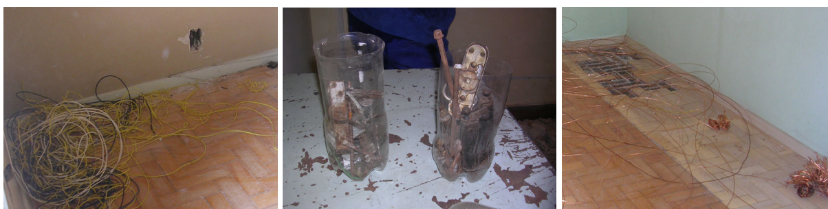
Figura 66: Fios descascados: reciclagem dos metais (material amorfo) (Empresa demolidora 05)
