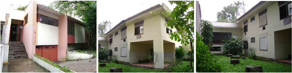
Figura 28: Edificação D: demolição D (Empresa 07)
