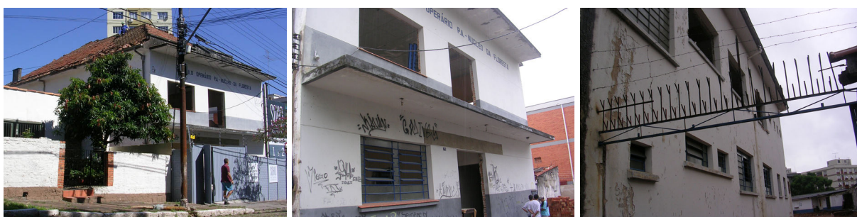
Figura 25: Edificação A: demolição A (Empresa 05)
