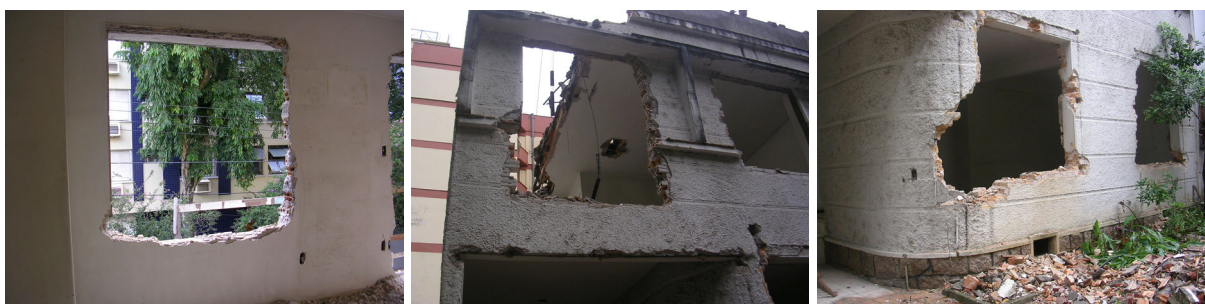
Figura 68: Estrutura com concreto, cerâmica e argamassa: materiais amorfos (Demolição C)
