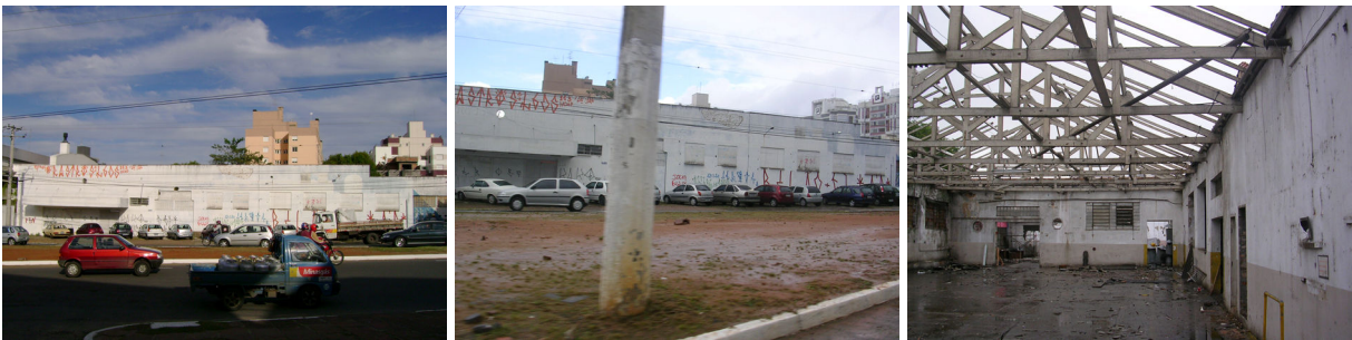
Figura 29: Edificação E: demolição E (Empresa 08)
