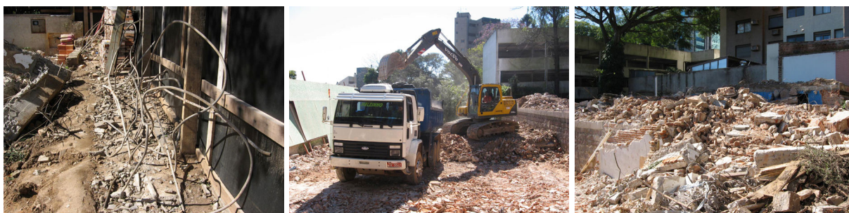
Figura 70: Estrutura com concreto, cerâmica e argamassa: materiais amorfos (Demolição D)
