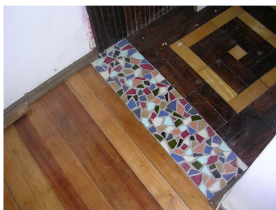
Figura 84: Restos de peças de revestimentos (Projetista 05)
