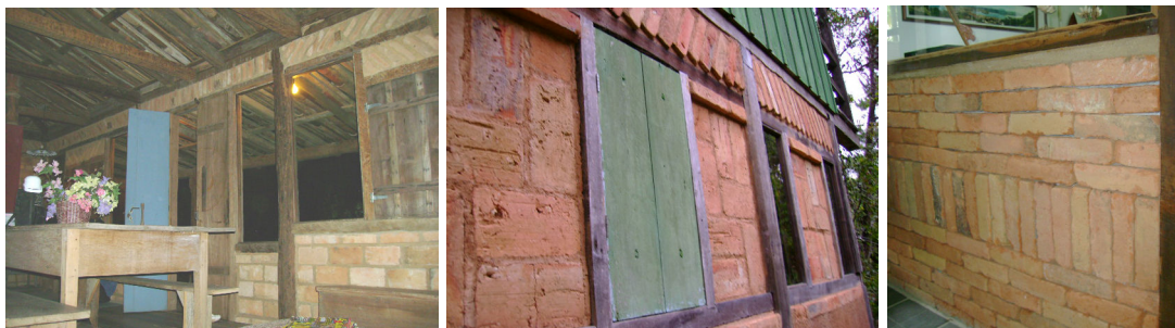
Figura 72: Tijolos de demolição e argamassa com barro
