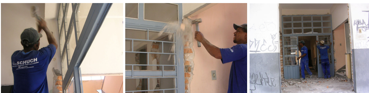
Figura 57: Esquadria com grandes dimensões (Demolição A)
