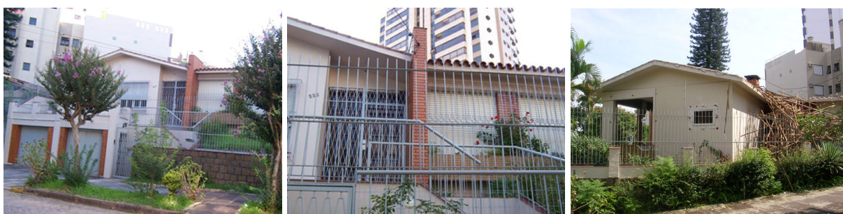
Figura 27: Edificação C: demolição C (Empresa 05)
