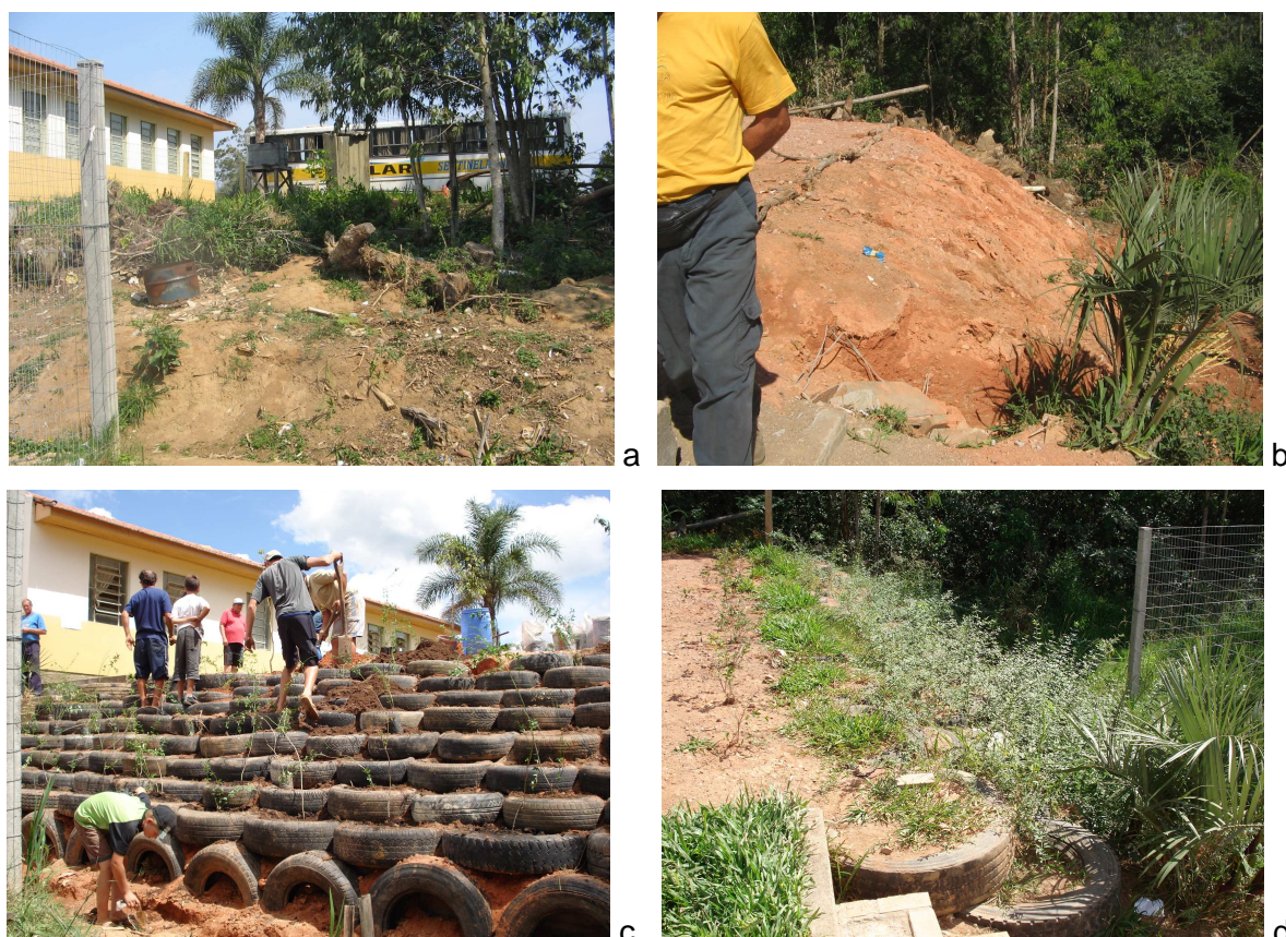
Figura 47: Aspectos do talude
