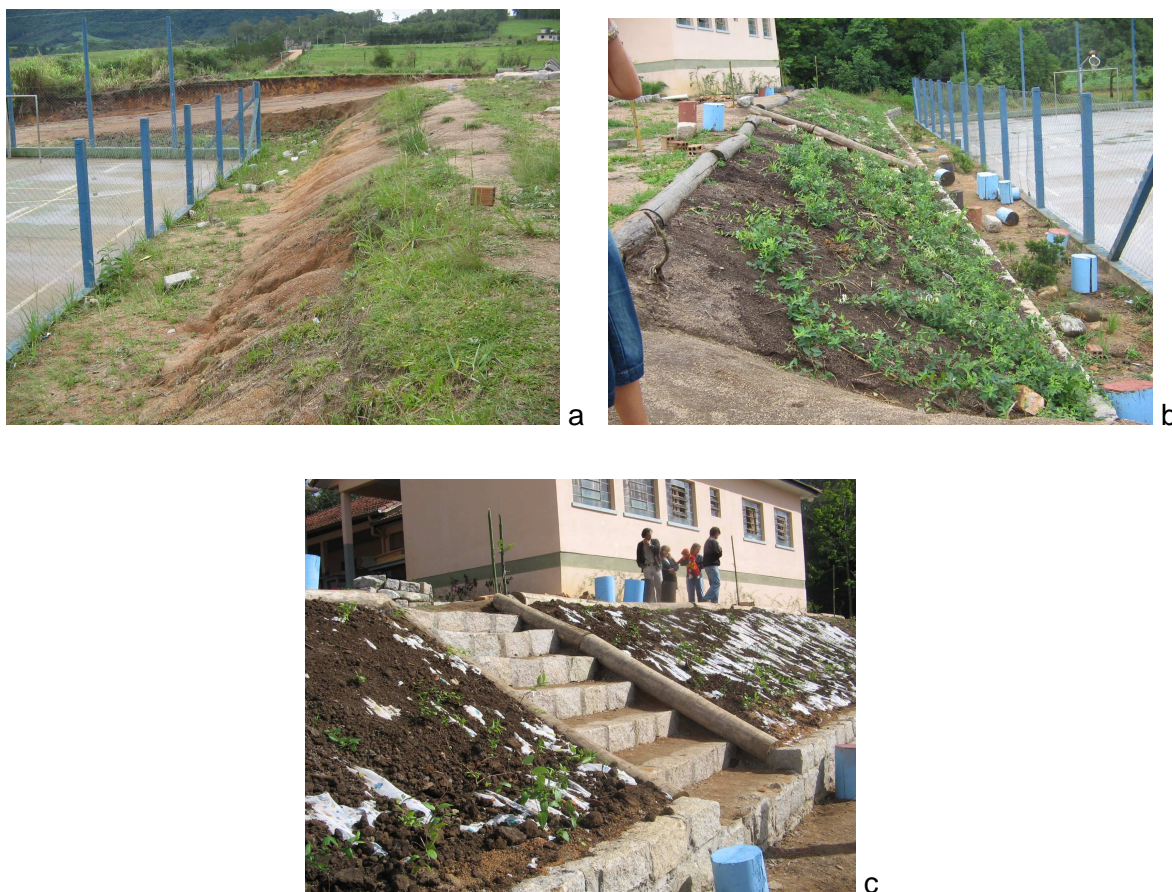
Figura 15: Controle de erosão no talude de acesso à quadra
