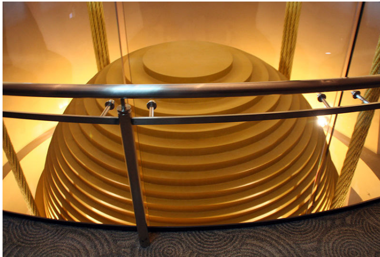
Figura 2.3 – Atenuador dinâmico sintonizado da Torre Taipei 101. Fonte: Wikipédia ( http://en.wikipedia.org/wiki/Taipei_101 ).
