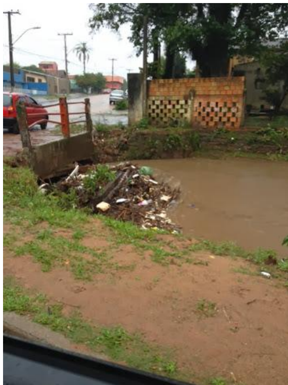
Figura 35 - Ponto de bloqueio na Rua Dona Izabel, e lixo acumulado impedindo a passagem do arroio pelas galerias. Fonte: Atavismo guasca
