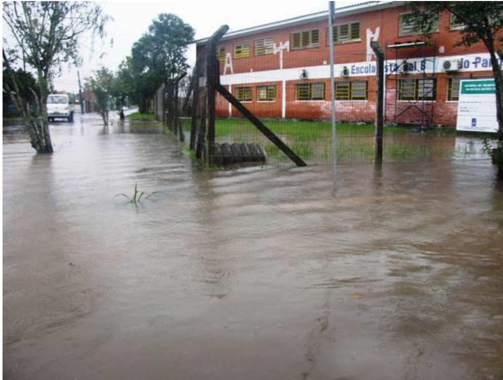
Figura 24 - Inundação na Escola Bairro do Parque, Bairro Novo Esteio. 13/07/2015. Fonte: Duarte de Esteio
