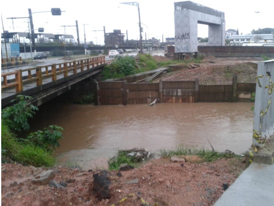
Figura 56 - Ponto de bloqueio, Av. Presidente Vargas, foto tirada no dia 17/07/2015, antes da finalização das obras da Av. Brasil
