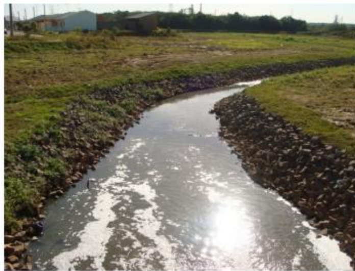
Figura 61 - Bacia de contenção do tipo in-line, arroio Guajuviras, com contenção de margens por enrocamento. Fonte: Canoas, 2011.
