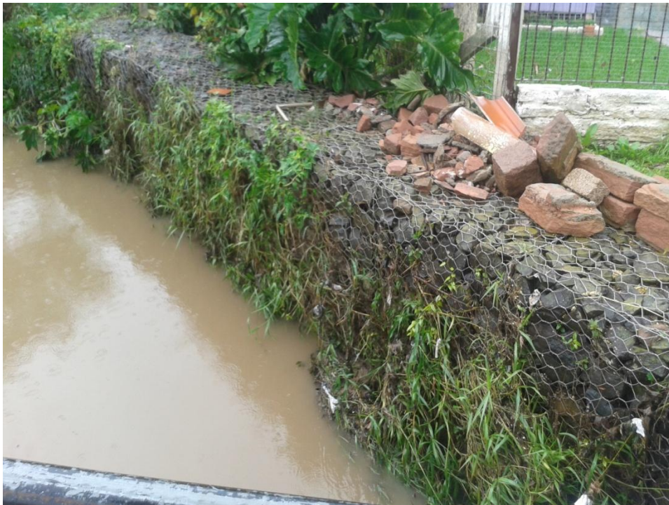
Figura 45 - Rua Bento Gonçalves, ponte sobre arroio Esteio. Muro de contenção de pedras construído pela Prefeitura, para evitar erosão do terreno.
