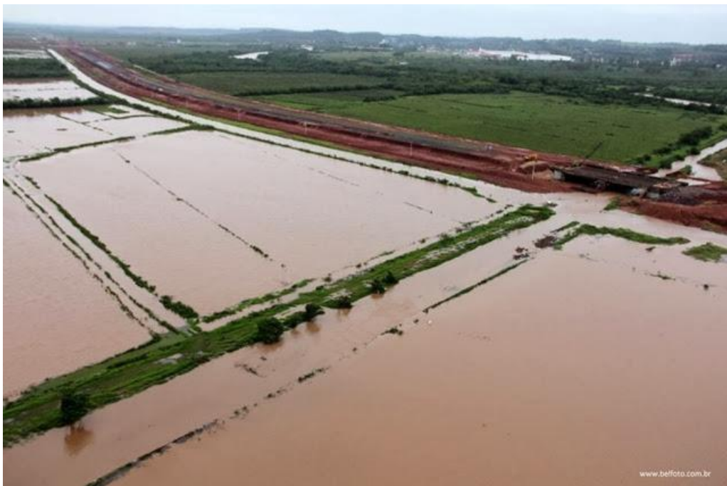
Figura 28 - BR 448 atuando como dique de contenção de inundações, outubro de 2013. Fonte: Belfoto imagens aéreas
