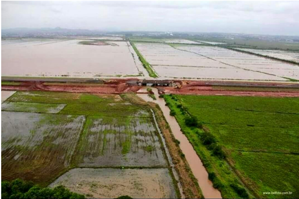
Figura 27 - BR 448 atuando como dique de contenção de inundações, outubro de 2013. Fonte: Belfoto imagens aéreas
