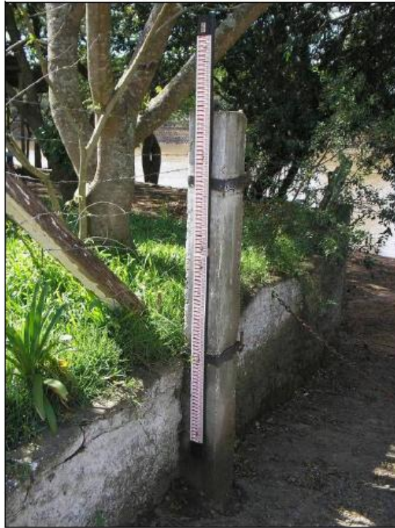
Figura 9 - Régua linimétrica com cota fluviométrica máxima de 6 m. Fonte: Bazzan, 2011.
