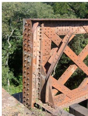
Figura (5.3) – Peças do contraventamento vertical – brackets – deformados por choques.
