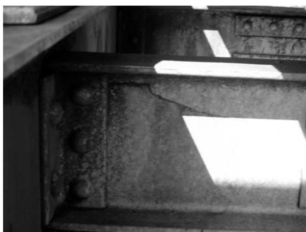
Figura (1.4) – Detalhe de trinca por fadiga na alma da longarina.
