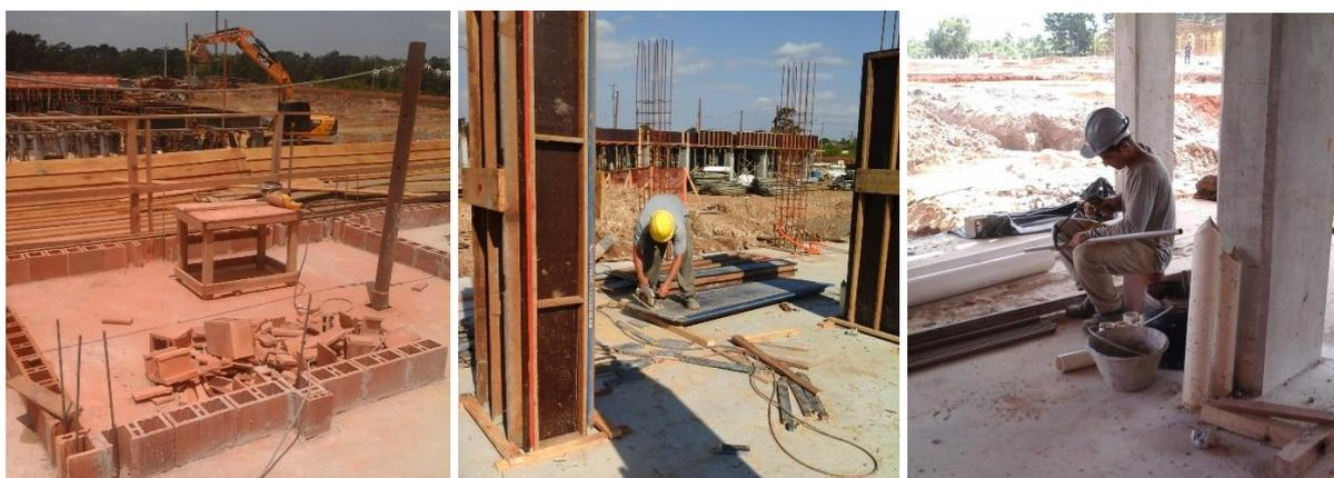
Figura 44 - Corte de material em local inapropriado
