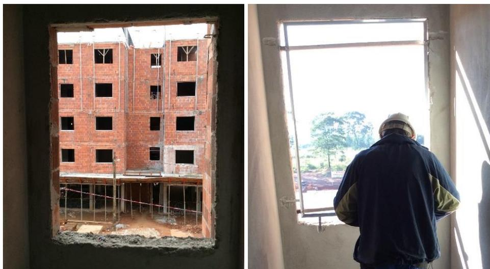
Figura 96 – Parede rebocada sem contramarco instalado no vão, e contramarco instalado sobre reboco, respectivamente
