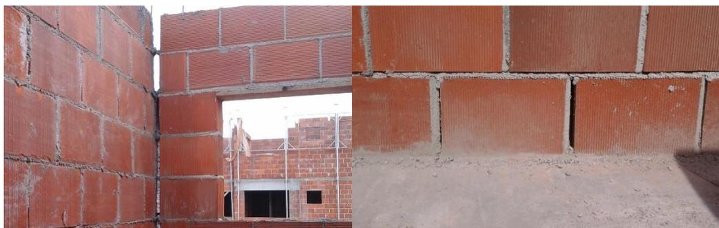
Figura 94 - Problemas de qualidade nas juntas verticais das alvenarias estruturais
