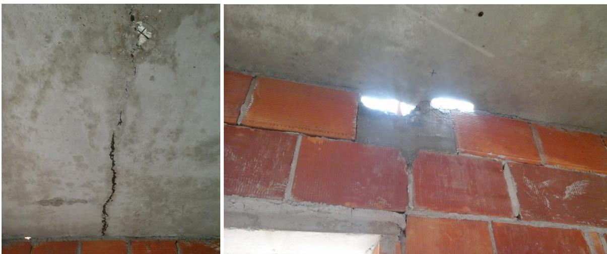
Figura 36 - Fissuras e buracos nas lajes pré-fabricadas
