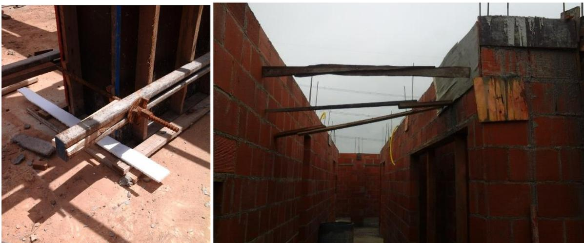
Figura 43 – Calço de madeira na barra de ancoragem e escoramento inadequado de fôrma
