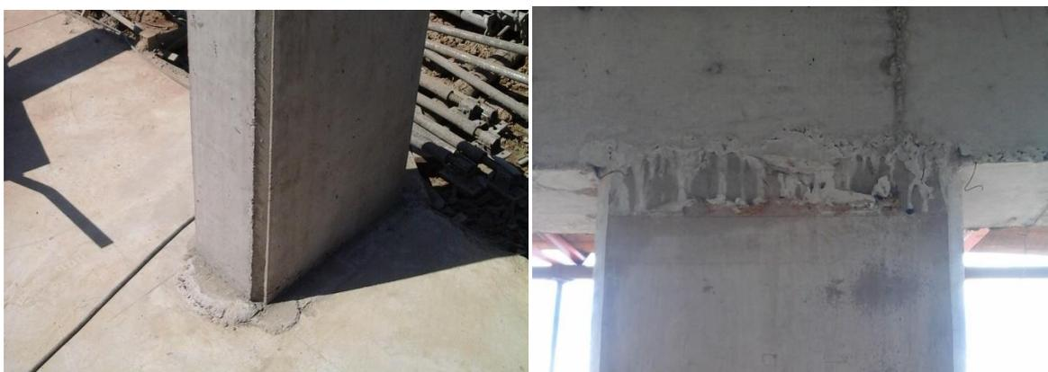
Figura 34 - Nata excedente na base e no topo do pilar, respectivamente
