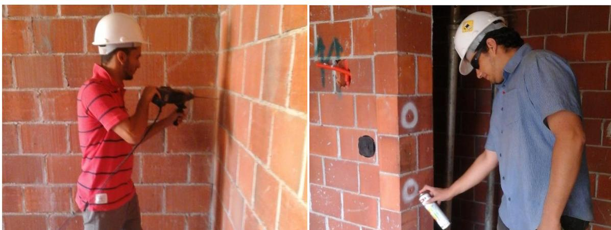
Figura 37 - Inspeção e identificação de reparo para o critério "preenchimento do graute"
