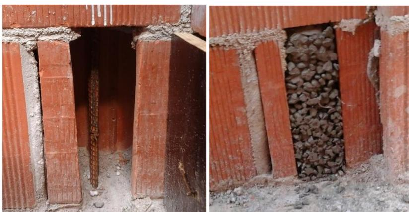
Figura 91 - Janela de inspeção desobstruída para inspeção, e janela após aplicação do graute
