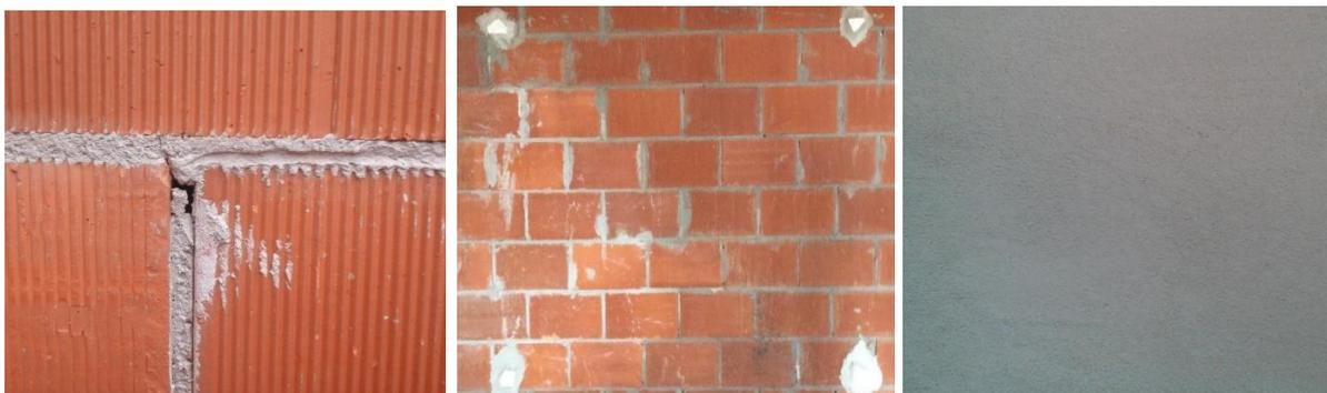
Figura 89 - Impossibilidade de verificação de juntas verticais e taliscas após execução do reboco
