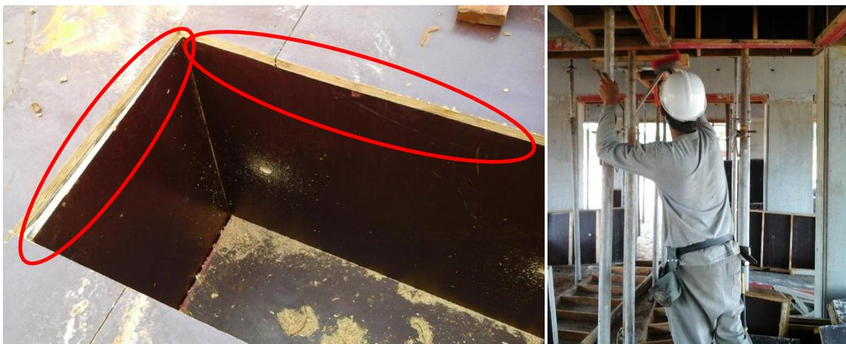
Figura 33 - Formas já montadas sem selagem executada e selagem posterior à montagem
