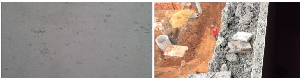
Figura 93 - Critérios de desempenho e limpeza reprovados na execução de reboco
