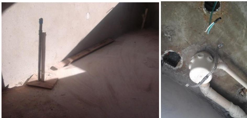
Figura 95 - Problemas de Qualidade no posicionamento e fixação das tubulações das redes hidráulicas, respectivamente
