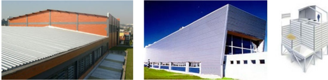
Figura 1.3: Exemplos de aplicações de telhas de aço formadas a frio de perfil trapezoidal.
