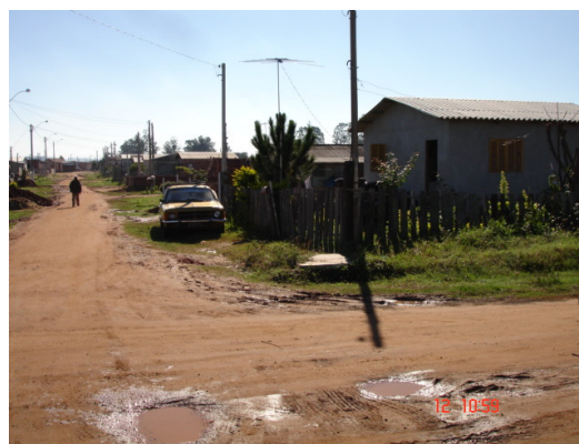
Falta de delimitação entre a via para veículos e o espaço de pedestres.
