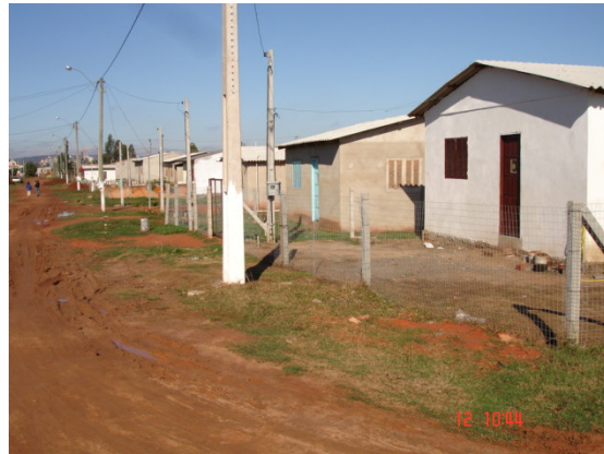
Retirada total da vegetação para implantação das residências
