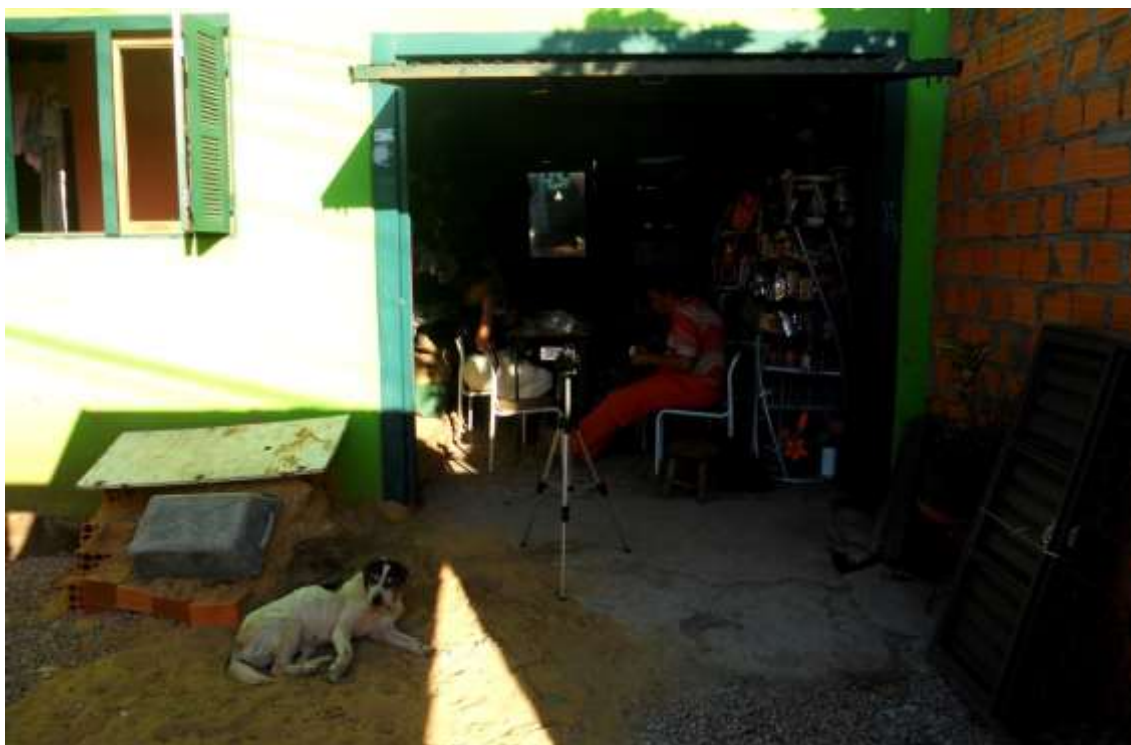
Imagem 1 - Fachada da casa de Cenira - durante a sua reforma, em 2013.
