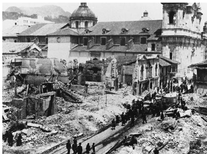
Figura 6-2 Edifícios destruídos, 9 de abril de 1948.
