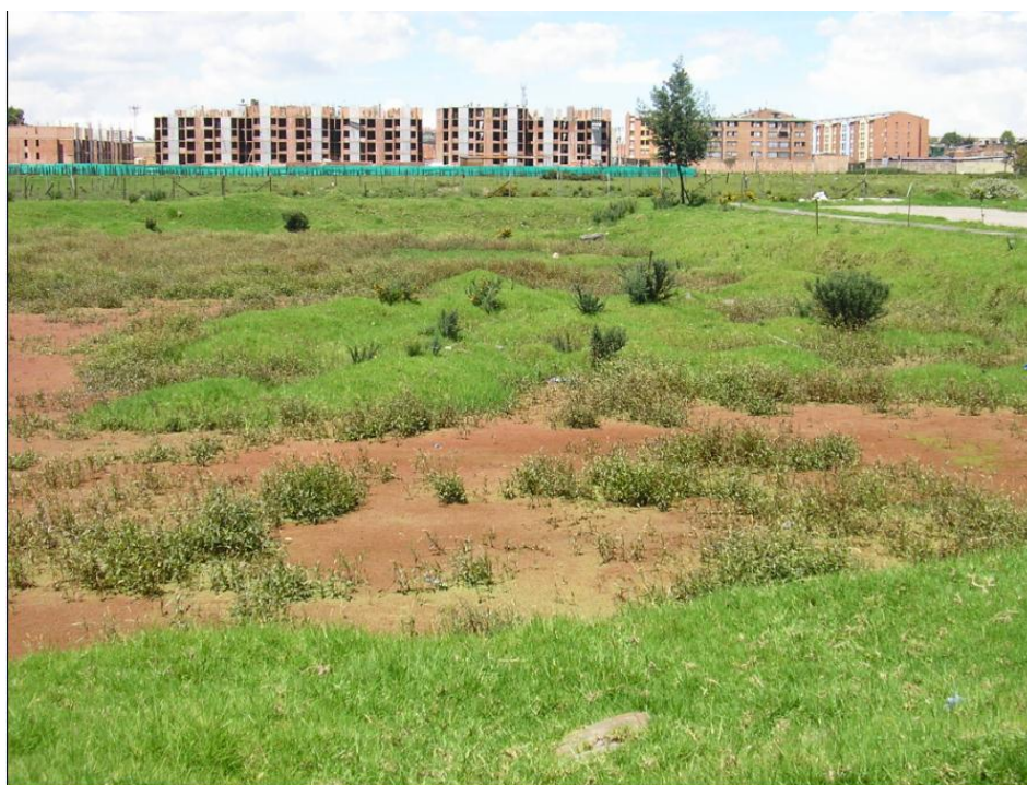
Figura 6-14 Construção de edifícios para apartamentos sobre terrenos que pertenciam ao banhado. FONTE: Fotografias próprias.
