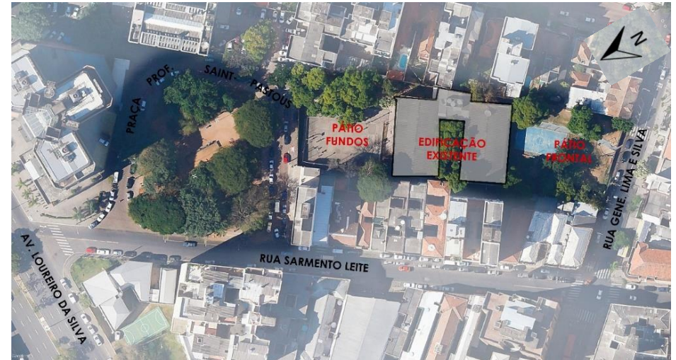
FIGURA 16: EEEF-RJ e Praça Saint-Pastous em destaque. Imagem demonstra a segregação criada pelo partido arquitetônico da escola no interior do seu terreno (criação de dois pátios sem comunicação direta) e na relação com seu entorno. (Fonte: Google Earth – intervenções na base da autora)
