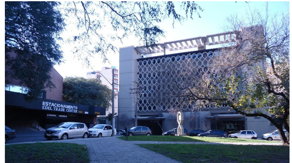
FIGURA 18: edifício da Farsul, à direita, e o acesso de estacionamento do edifício Edel Trade Center. (Fonte: Arquivo pessoal)
