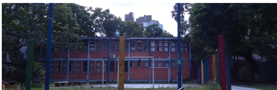
FIGURA 20: fotografias da escola vista de um prédio vizinho, das suas empenas com lindeiros e da fachada principal. Nota-se que não há nenhum tratamento arquitetônico especial para tornar a edificação atrativa e que a manutenção deixa a desejar. (Fonte: arquivo pessoal)
