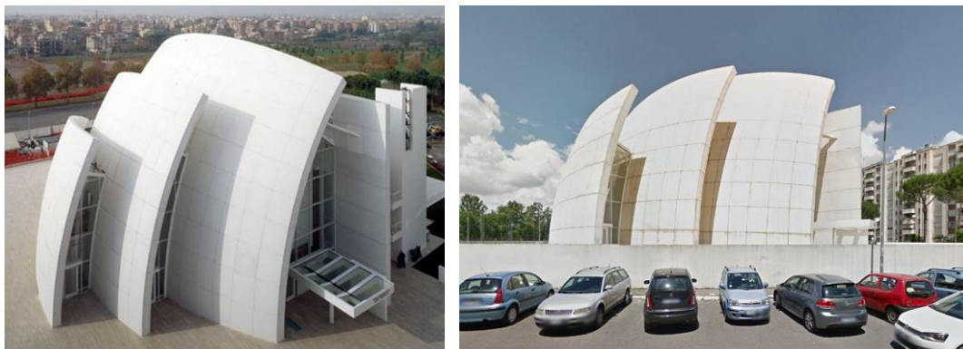
(a) (b) Figura 20 – Igreja Dives in Misericordia , em Roma. Estrutura em concreto branco aparente com utilização do cimento com \text{TiO}_2 na composição: (a) foto logo após a conclusão, em 2003 (fonte: http://www.arcvision.org/wp-content/uploads/2003/10/chiesa-dives-in-misericordia-2.jpg ); (b) foto no ano de 2014 (fonte: google street view).
