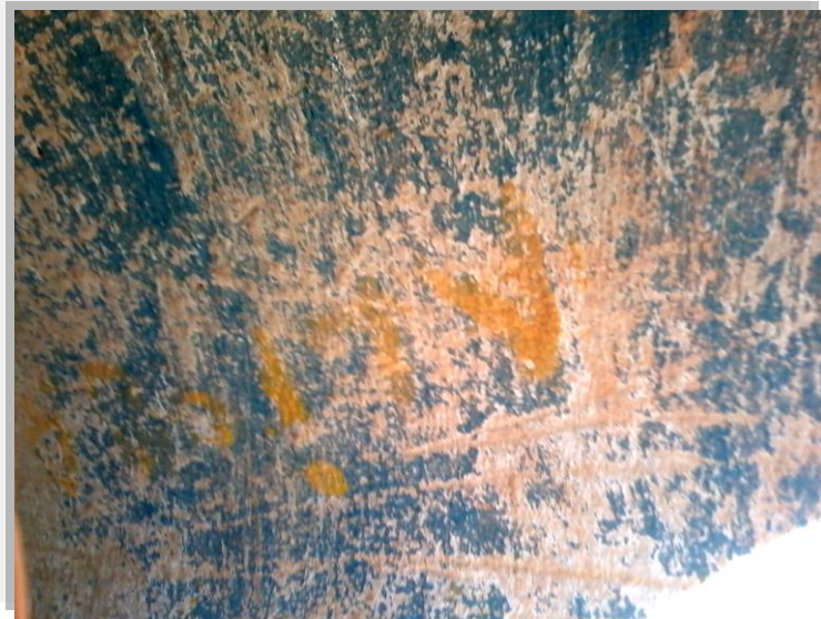
Fotografia 5 - Detalhes da vista interna dos tubos de concreto.
