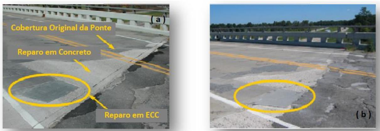
Figura 17 – Aparência das seções reparadas da ponte após a execução (a) e após cinco anos de exposição ao tráfego e condições ambientais (b) (GARCEZ, 2009).
