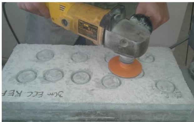
Figura 59 - Lixamento do compósito no intuito de regularizar a superfície.
