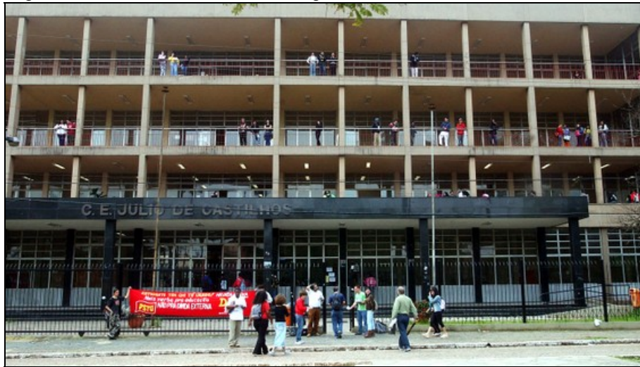
Figura 2 – Parte da fachada do Colégio Estadual Júlio de Castilhos
