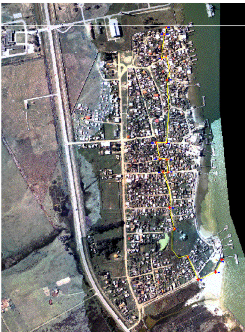
Figura 22 – Área atingida pelo processo de expansão portuária na localidade da Barra Velha
