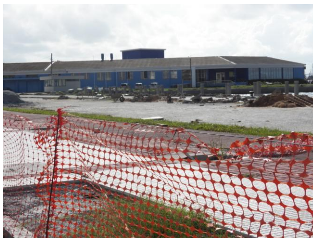
Figura 25 – Canteiro de obras do Projeto de Recuperação do cais do Rincão da Cebola no centro de Rio Grande (Foto 1)
