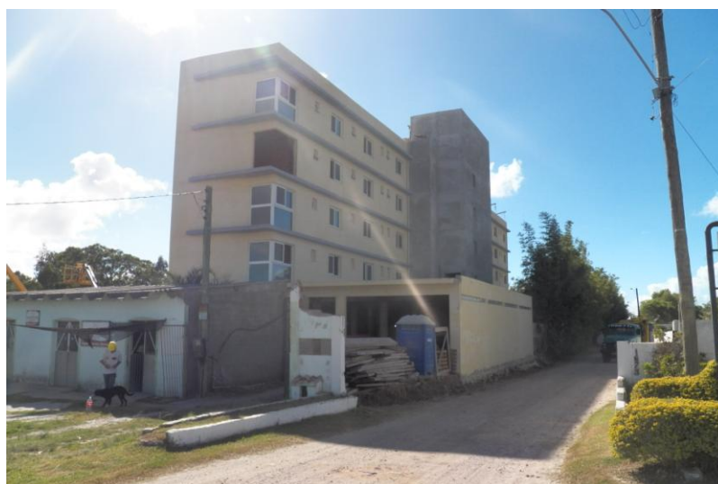
Figura 29 – Obras do Hotel da Rede Pacific Hotéis localizado na Av. Itália na rodovia que liga a cidade do Rio Grande ao Balneário Cassino
