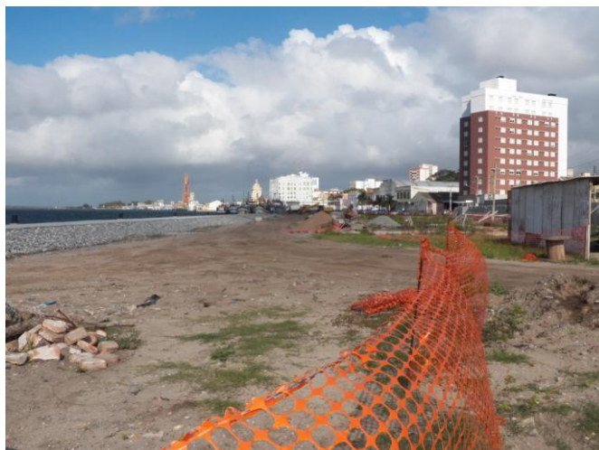
Figura 26 – Canteiro de obras do Projeto de Recuperação do cais do Rincão da Cebola no centro de Rio Grande (Foto 2)
