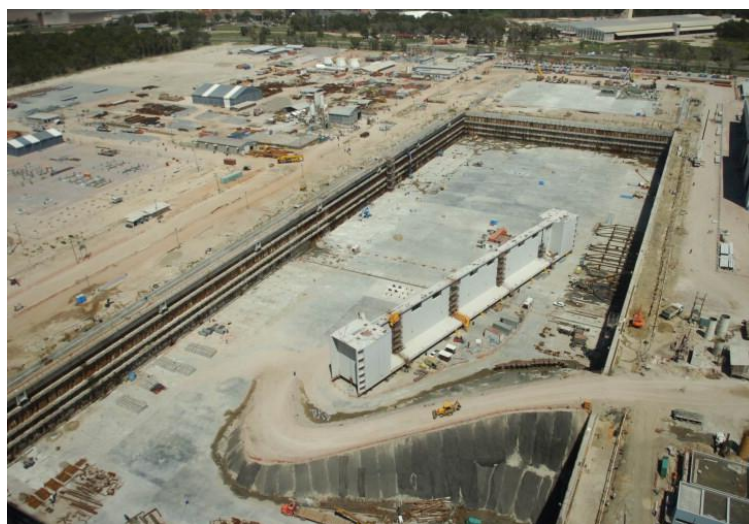
Figura 10 – Dique seco no Estaleiro Rio Grande
