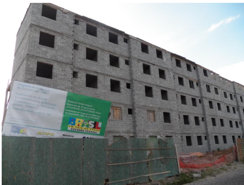
Figura 19 – Canteiro de obras do Condomínio Residencial Getúlio Vargas II (ano 2012)
