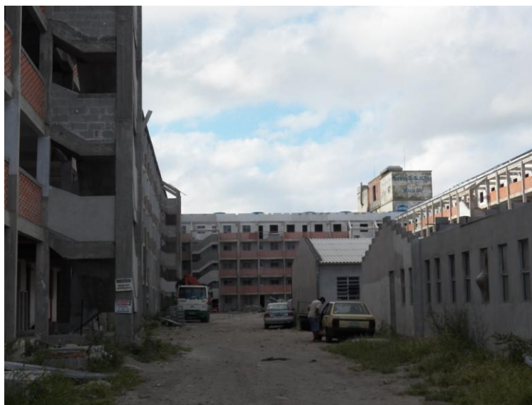
Figura 18 - Canteiro de obras do Condomínio Residencial Getúlio Vargas I (ano 2012)
