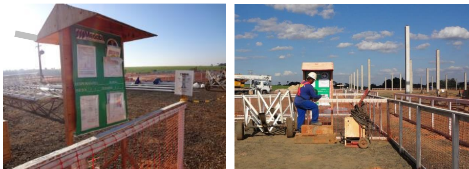
Figura 54 – Painel inserido em painéis na área de montagem.
