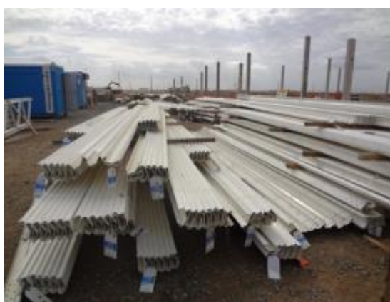
Figura 44 – Identificação das peças dos diferentes prédios por etiquetas coloridas.
