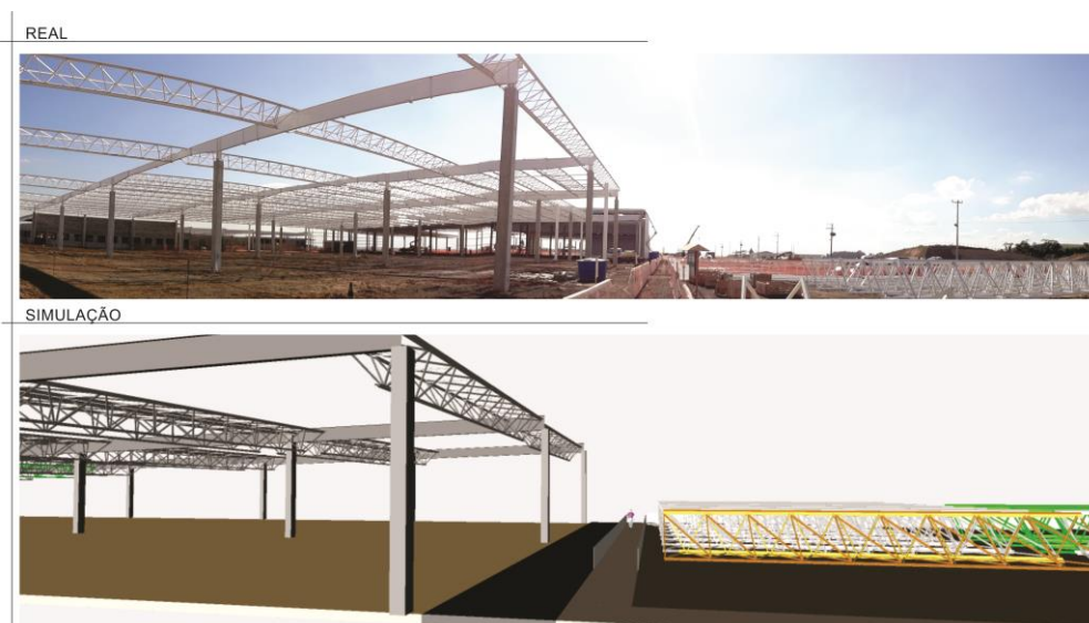
Figura 82 - Comparação simulação 4D com obra real – ângulo 3.
