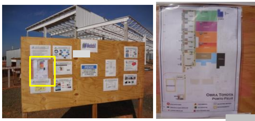
Figura 53 – Painel empregado no canteiro de montagem.
