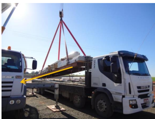
Figura 69 – Carga desbalanceada no skid durante descarregamento.
